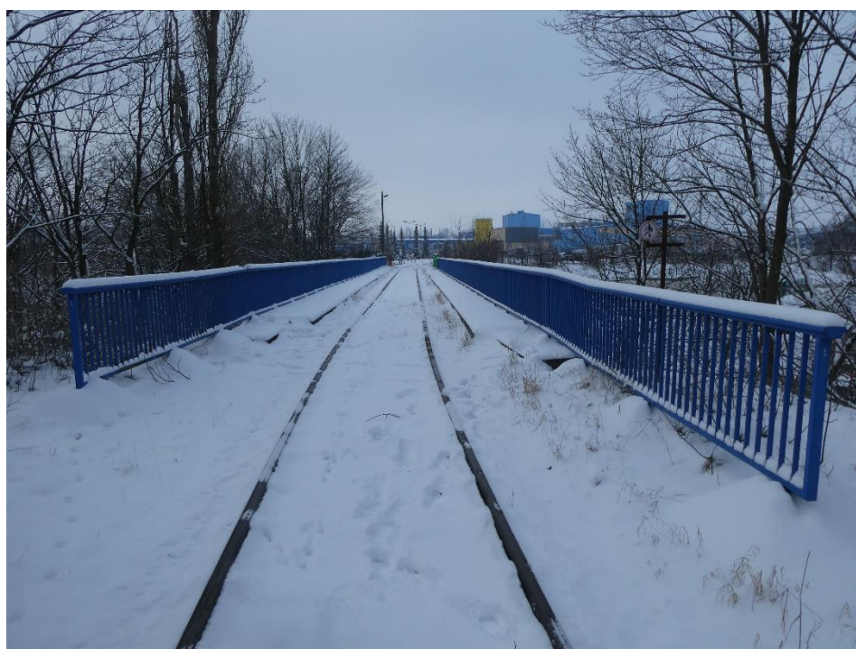
Bild 4: Oberbauansicht, Blick nach hinten (Stand: 01.2024)
