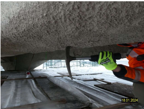
S2024_LÄNGSTRÄGER SPRITZMÖRTELAUFTRAG HOHLSTELLE_SÜD FELD 2
