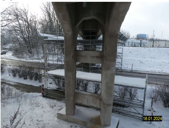
S2024_PFEILER 1 SPRITZMÖRTELAUFTRAG
