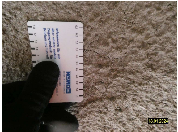
S2024_LÄNGSTRÄGER SPRITZMÖRTELAUFTRAG NETZRISSE_FELD 1_2
