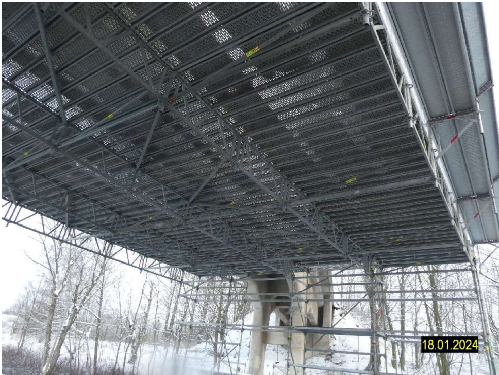
S2024_SCHUTZGERÜST FAHRBAHN_FELD 2
