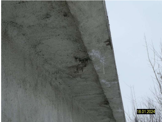
S2024_KAPPE AUSSINTERUNG_UNTEN SÜD
