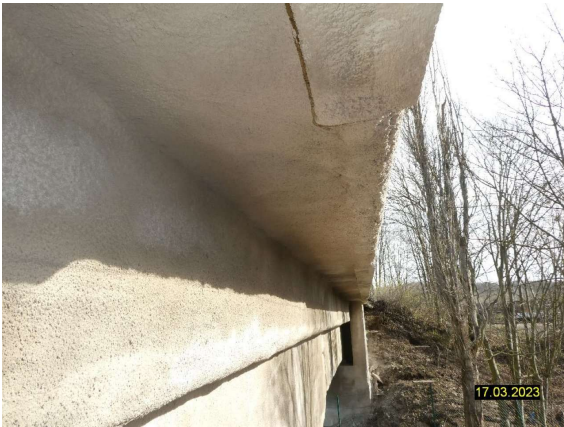
S2023_LÄNGSTRÄGER AUSKRAGUNG SPRITZMÖRTELAUFTRAG_NORD FELD 1_2
