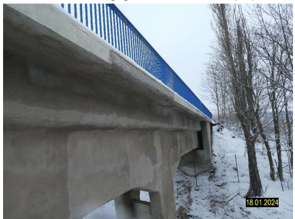
S2024_LÄNGSTRÄGER AUSKRAGUNG SPRITZMÖRTELAUFTRAG_NORD FELD 1_2
