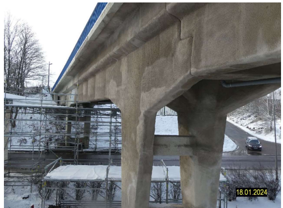
S2024_ÜBERBAU SPRITZMÖRTELAUSTRAG_OST FELD 2
