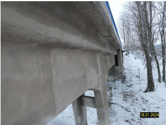
S2024_LÄNGSTRÄGER AUSKRAGUNG SPRITZMÖRTELAUFTRAG_FELD 1_2
