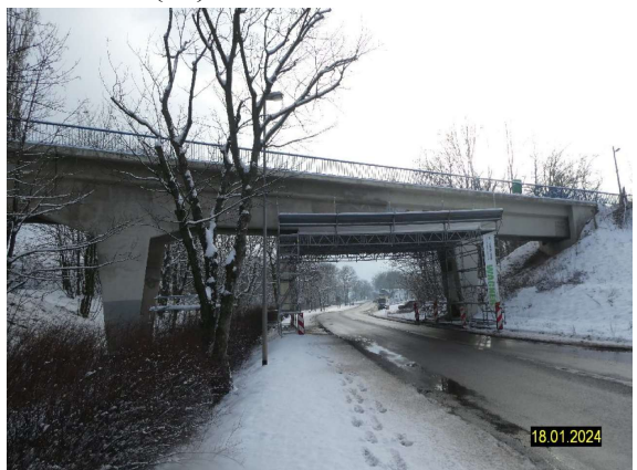
S2024_SCHUTZGERÜST FAHRBAHN DURCHHÄNGEND_FELD 2
