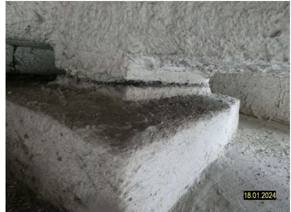
S2024_LAGER NICHT FUNKTIONSFÄHIG
