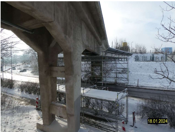
S2024_ÜBERBAU_LÄNGSTRÄGER SPRITZMÖRTELAUFTRAG_OST FELD2_1
