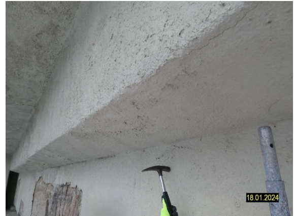
S2024_LÄNGSTRÄGER SPRITZMÖRTELAUFTRAG HOHLSTELLE_NORD FELD 2
