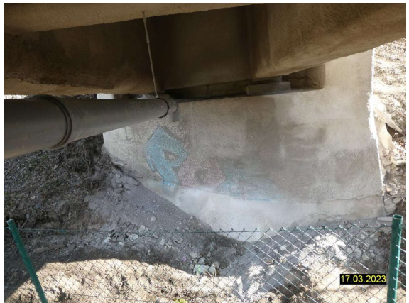
S2023_LÄNGSTRÄGER SPRITZMÖRTELAUFTRAG_FELD 1
