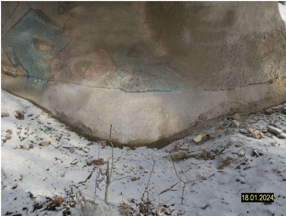
S2024_BÖSCHUNG ERODIERT_OST
