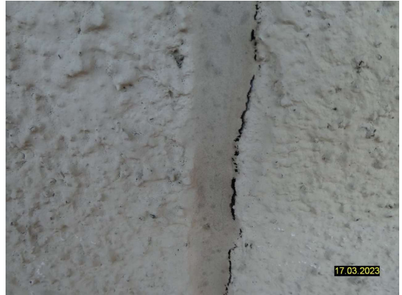
S2023_ÜBERBAU RF-FLANKEN ABGERISSEN
