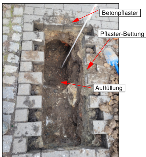
Foto 3: Abbruch Schurf wegen Kabellage Tiefe -0,90 m
