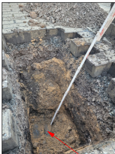
Foto 3: Abbruch Schurf wegen Kabellage Tiefe -0,70 m
