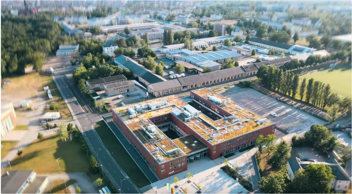
Abbildung 5: Njumii 1 mit provisorischem Parkplatz
