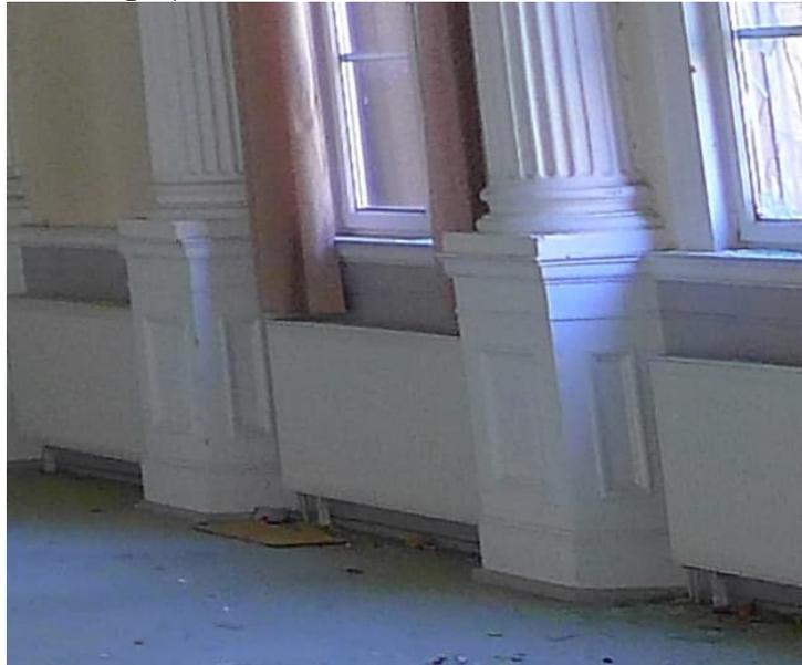
befestigen mit Schrauben, inkl. Herstellen von Gehrungen zu angrenzenden Platten an den Stützen, aufgesetzte Zierplatten werden gegen Zierplatten aus Sperrholz in Originalabmessung ersetzt.
