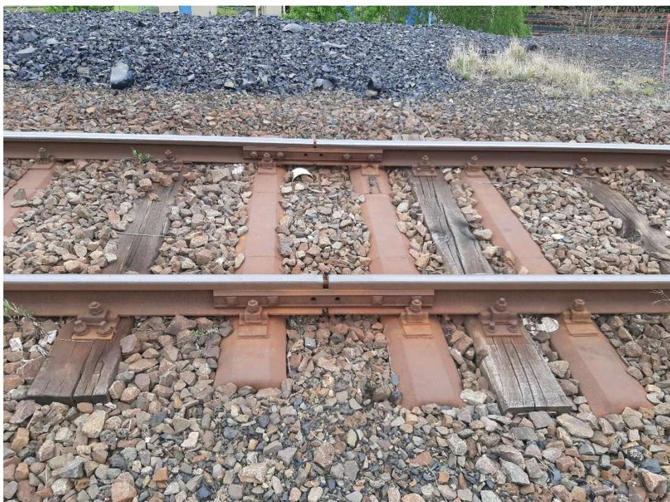
**Bild 12:** unplanmäßige Spaltmaße an Schienenstößen (Stand: 05.2024)
