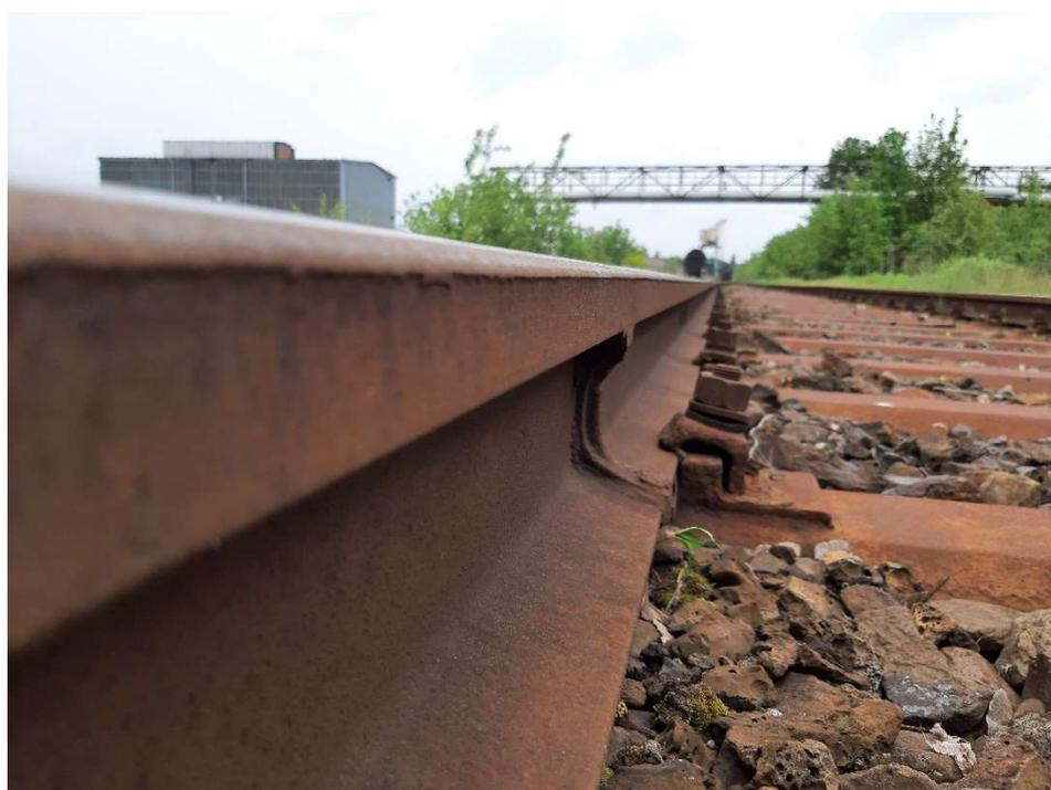
**Bild 10:** Gradbildung an Schienen (Stand: 05.2024)
