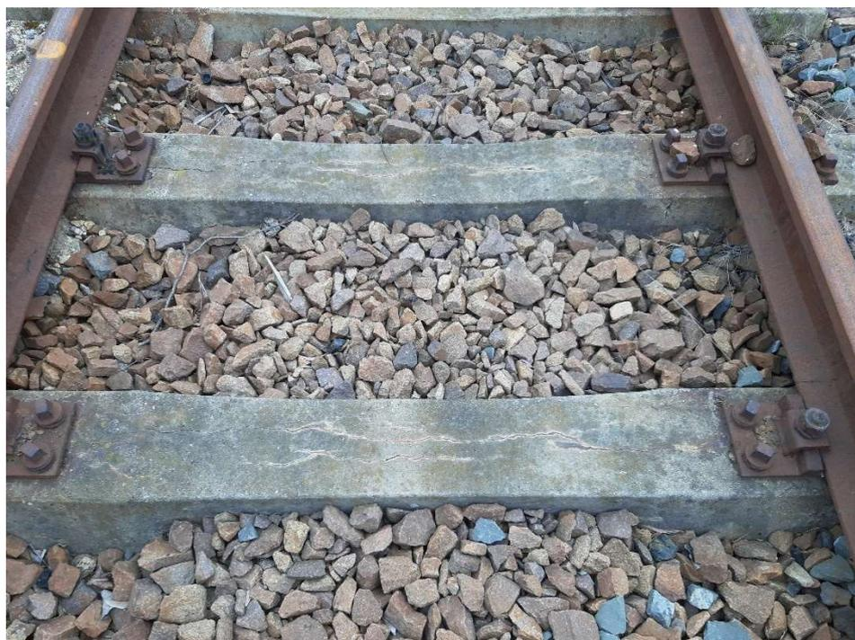
**Bild 7:** schadhafte Betonschwelle (Stand: 05.2024)
