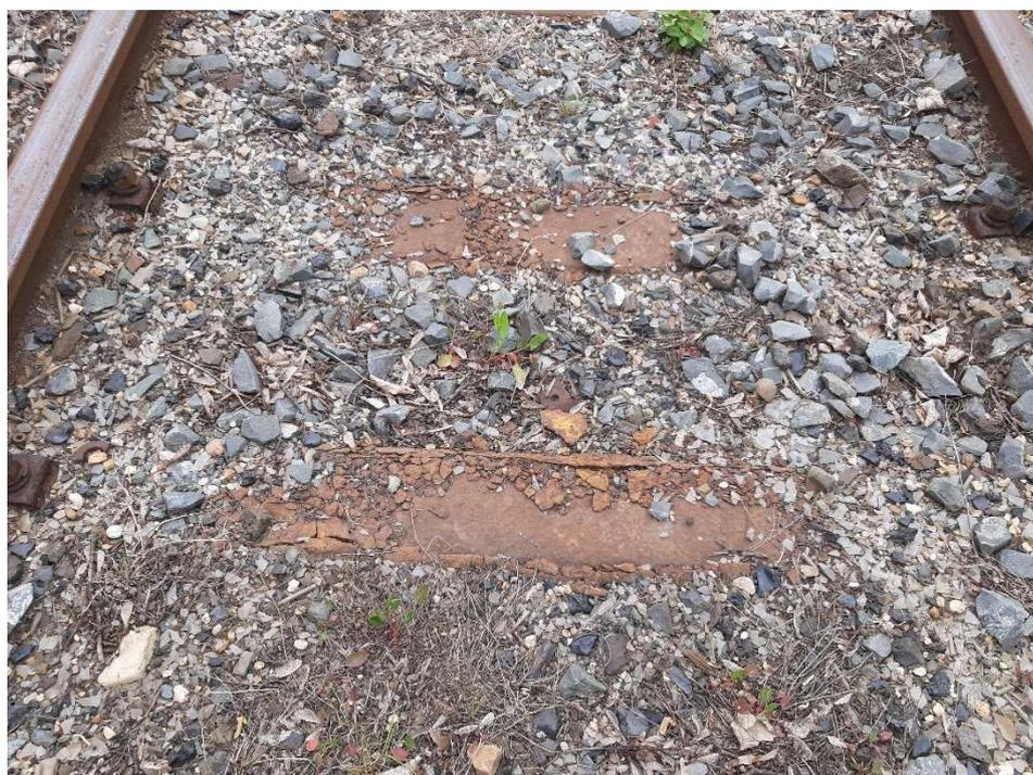
**Bild 8:** schadhafte Stahlschwellen (Stand: 05.2024)
