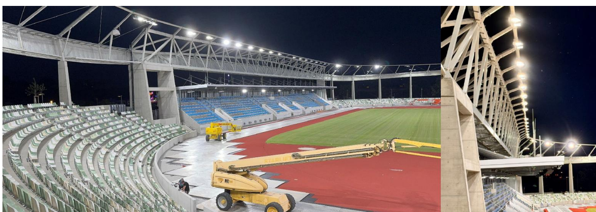
Foto: Blick von Westkurve auf Nordtribüne
