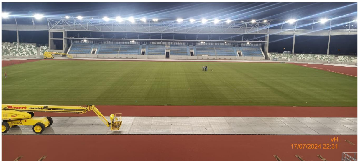
Foto: Blick von Südtribüne auf Nordtribüne
