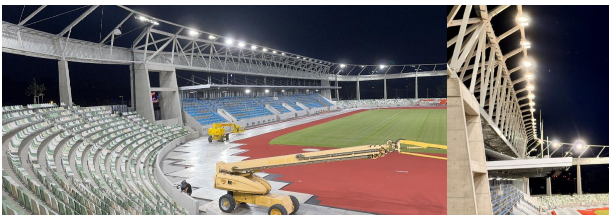
Foto: Blick von Westkurve auf Nordtribüne
