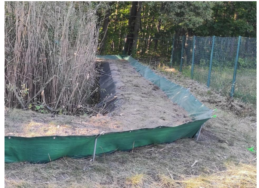
Schräg nach Außen geneigtes Aufstellen des Reptilienzauns, damit eingeschlossene Tiere über den Zaun abwandern können. (habit.art)
