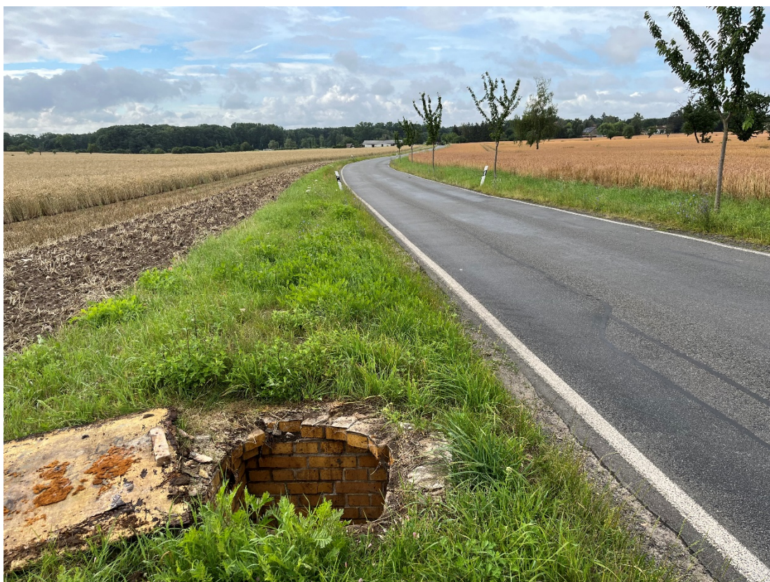
Bild 10: Blick in südlicher Richtung auf Schacht (0+475,000)
