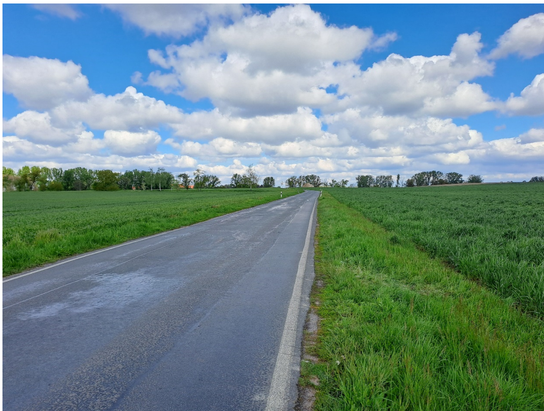
Bild 7: Blick in nordlicher Richtung auf Bestandsweg (0+250,000)
