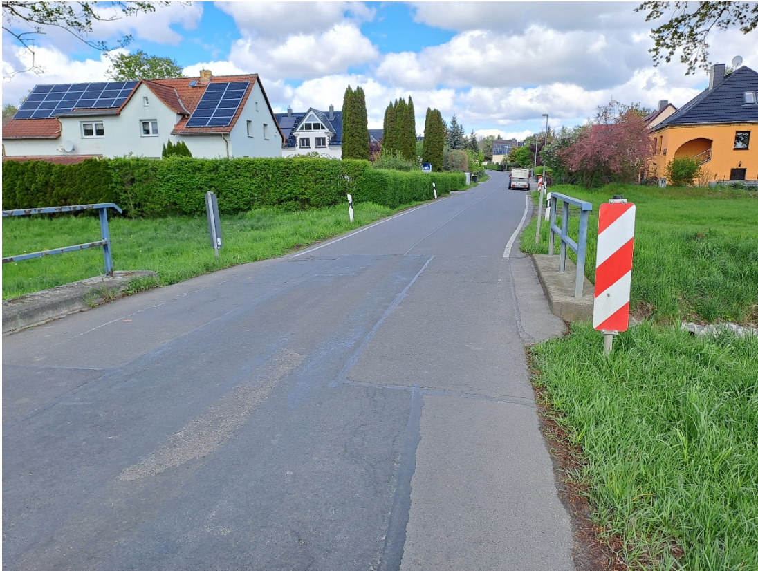
Bild 17: Blick in nordlicher Richtung auf Bauende (0+785,000)
