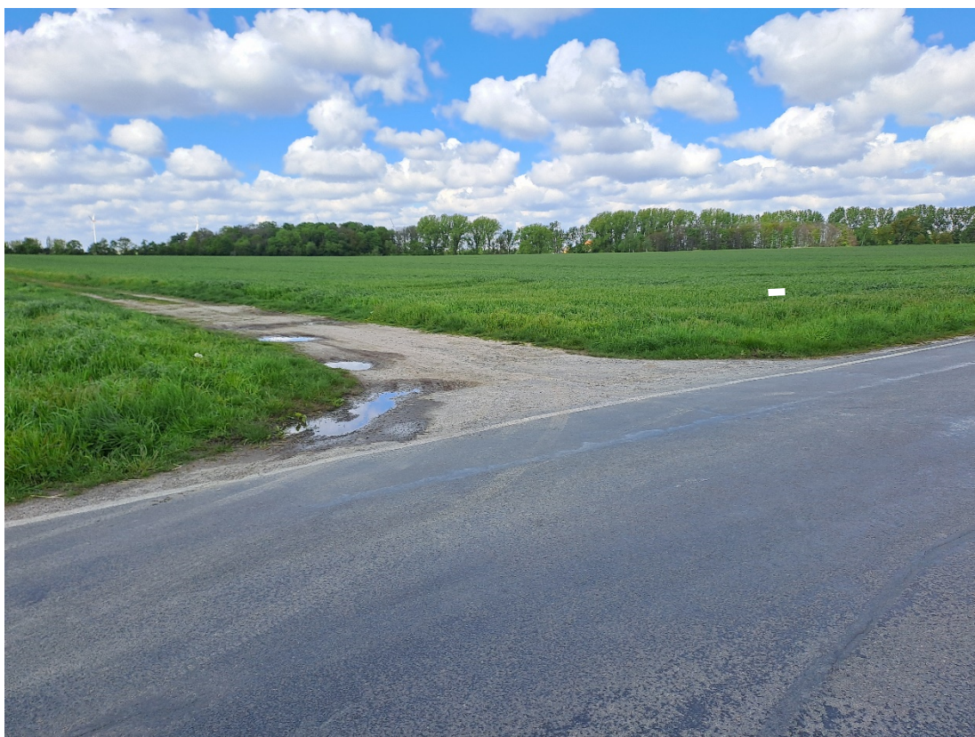
Bild 6: Blick in nordwestlicher Richtung auf Einmündung Feldzufahrt (0+150,000)
