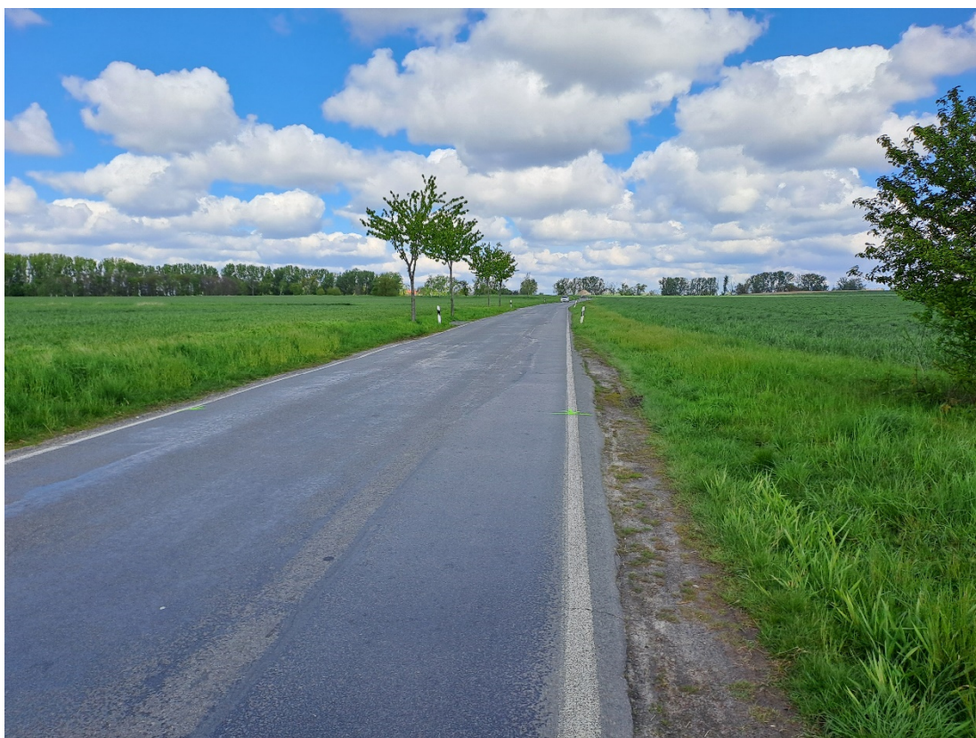
Bild 4: Blick in nordlicher Richtung auf Bestandsweg (0+090,000)
