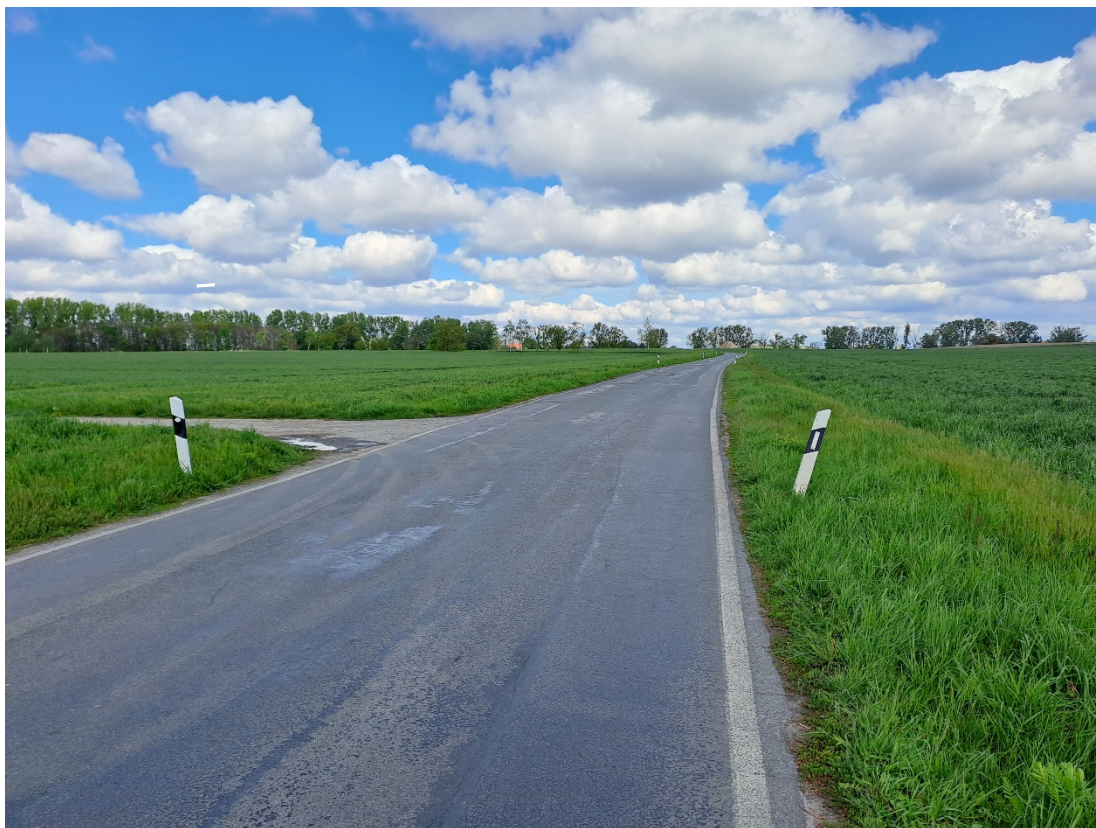
Bild 5: Blick in nördlicher Richtung auf Bestandsweg (0+140,000)
