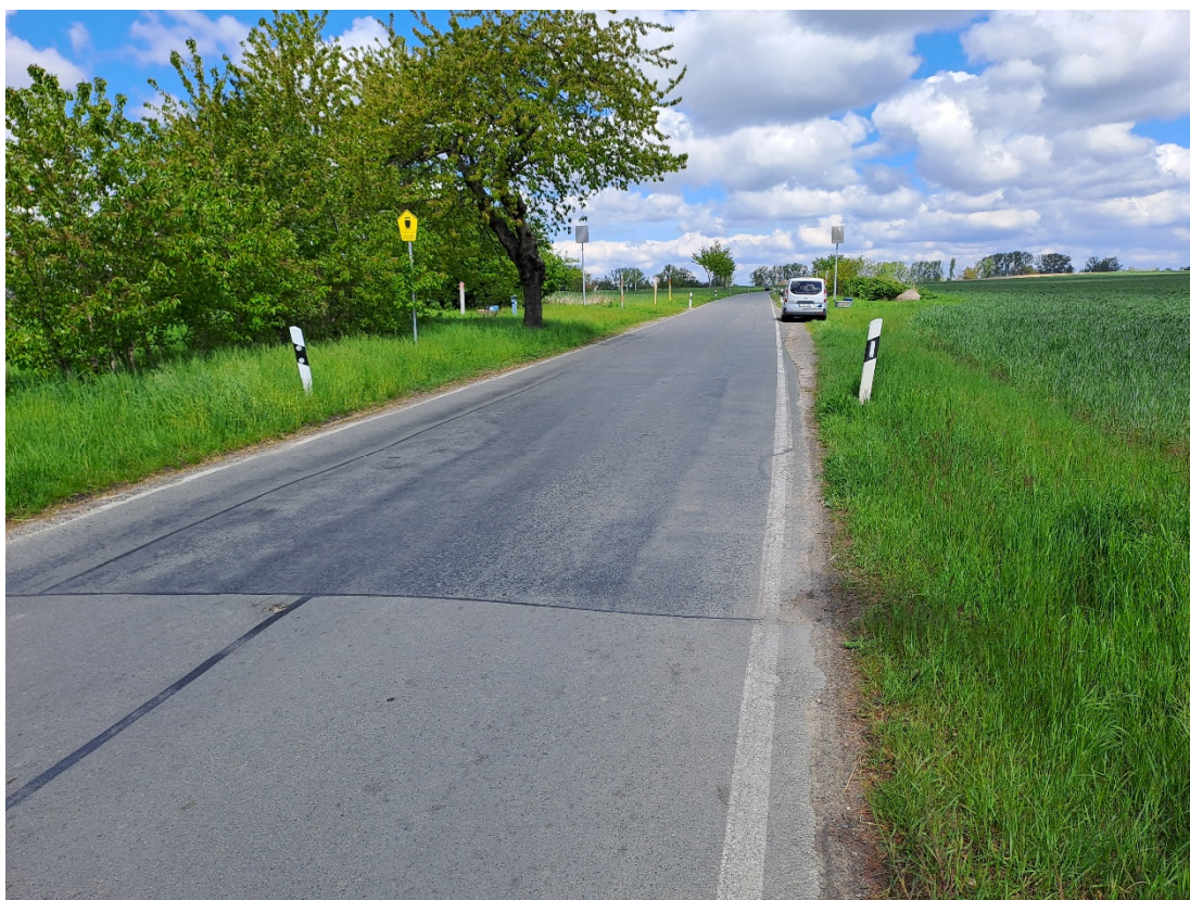
Bild 2: : Blick in nördlicher Richtung in Seegeritz auf Bauanfang (0+000,000)
