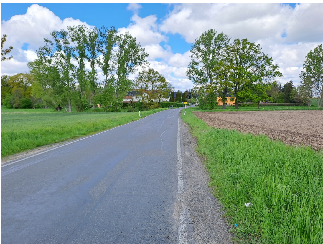
Bild 14: Blick in nördlicher Richtung auf Bestandsweg (0+690,000)
