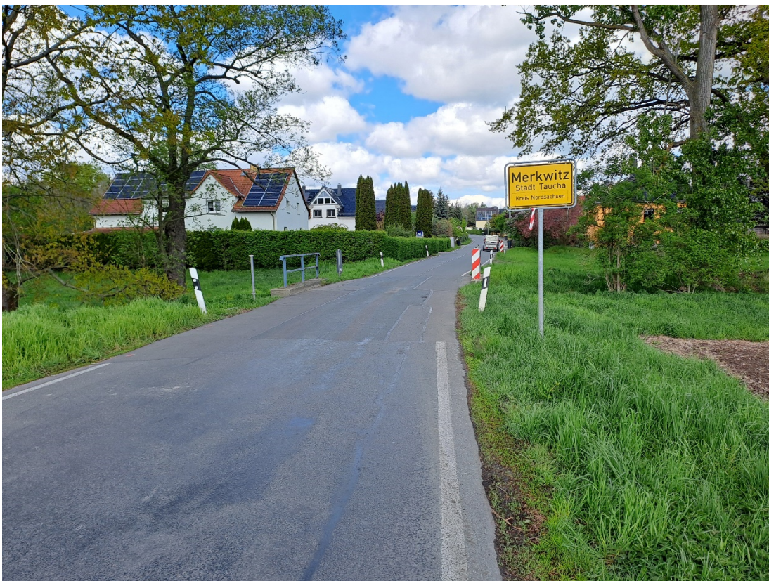
Bild 16: Blick in nordlicher Richtung auf Brücke Hasengraben (0+770,000)
