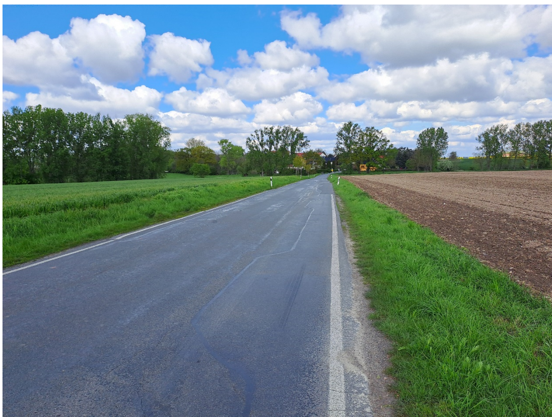
Bild 12: Blick in nördlicher Richtung auf Bestandsweg (0+530,000)
