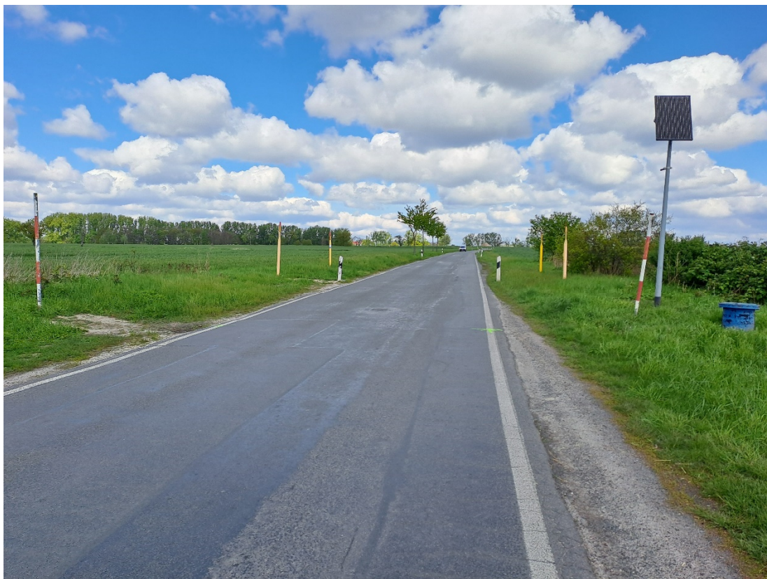
Bild 3: Blick in nordlicher Richtung auf Bestandsweg (0+050,000)
