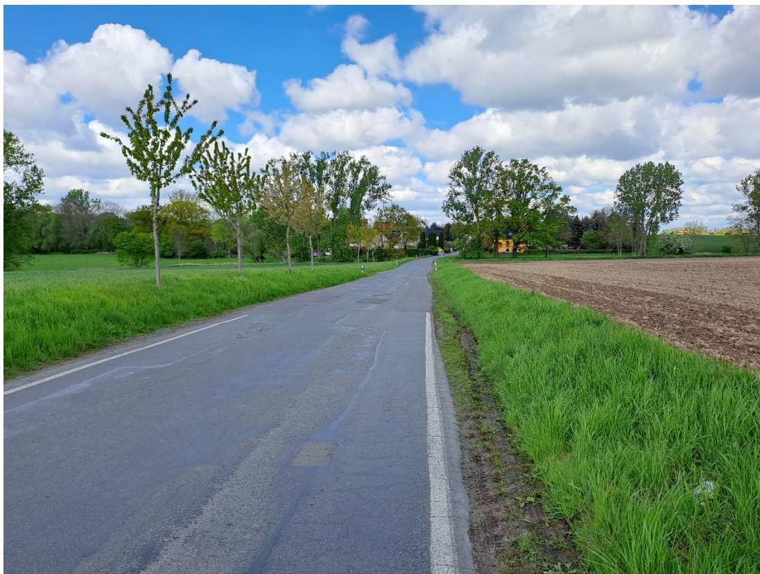
Bild 13: Blick in nördlicher Richtung auf Bestandsweg (0+635,000)
