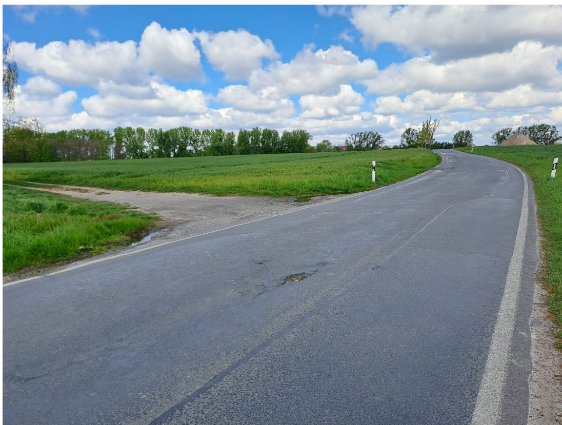
Bild 8: Blick in nordlicher Richtung auf Einmündung Feldzufahrt (0+370,000)
