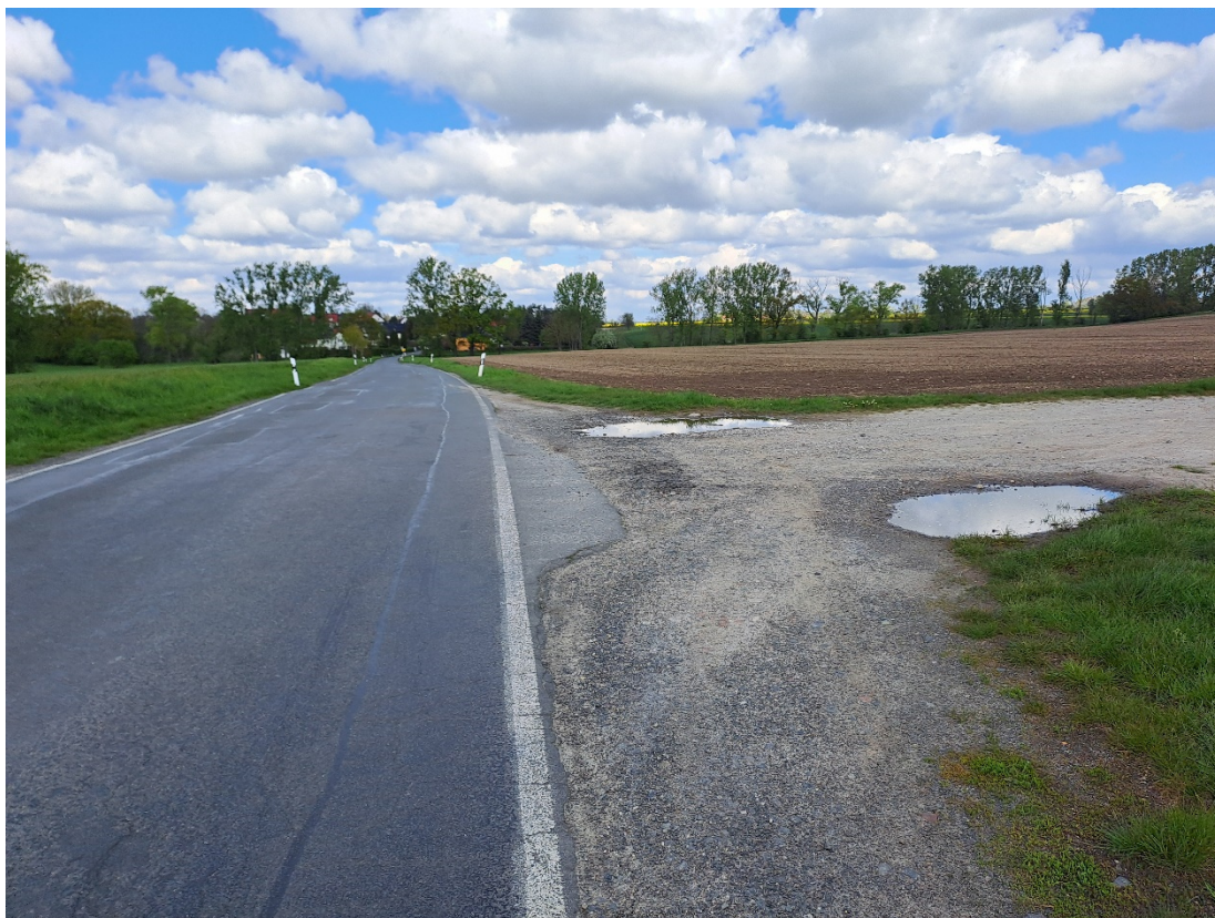
Bild 11: Blick in nördlicher Richtung auf Einmündung Feldzufahrt (0+500,000)
