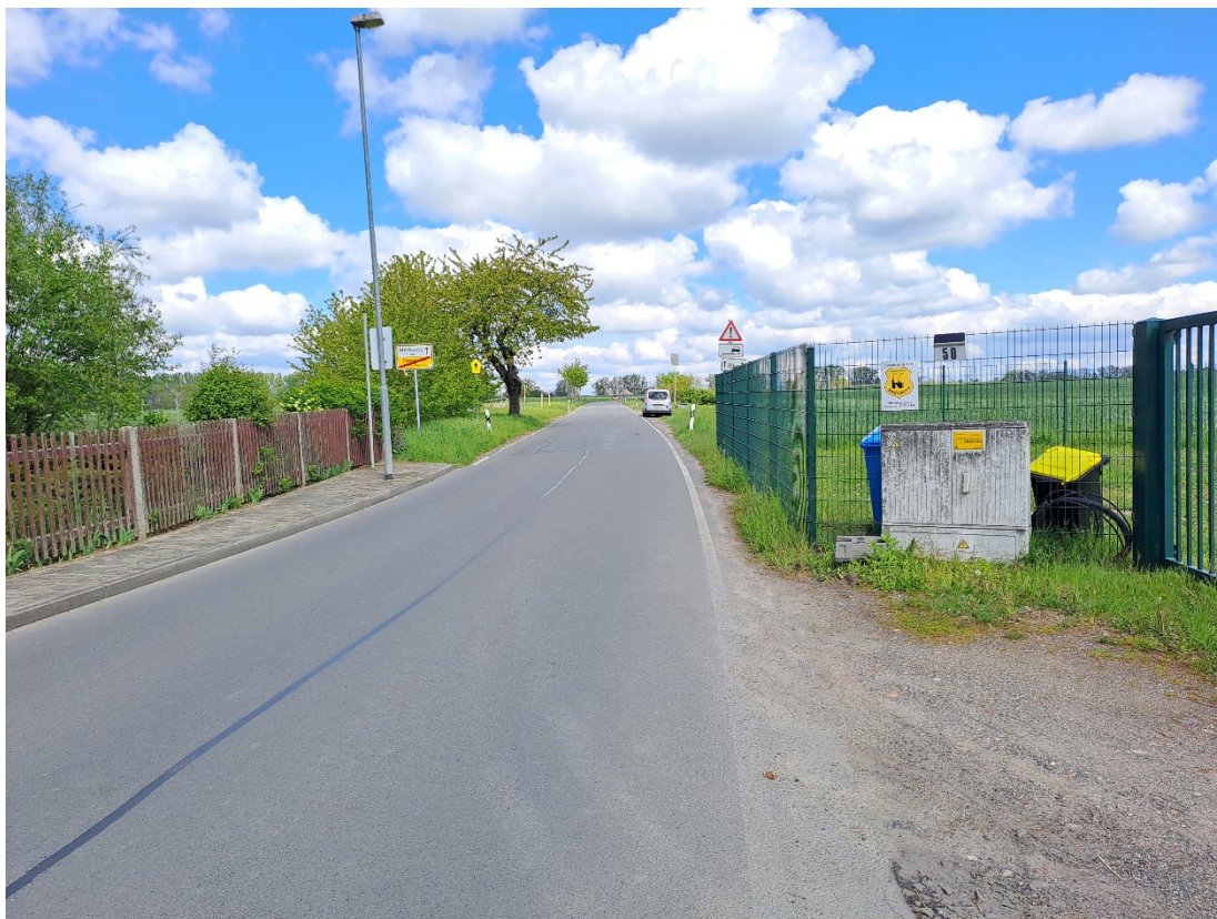
Bild 1: Blick in nördlicher Richtung in Seegeritz auf Bauanfang (0+000,000)
