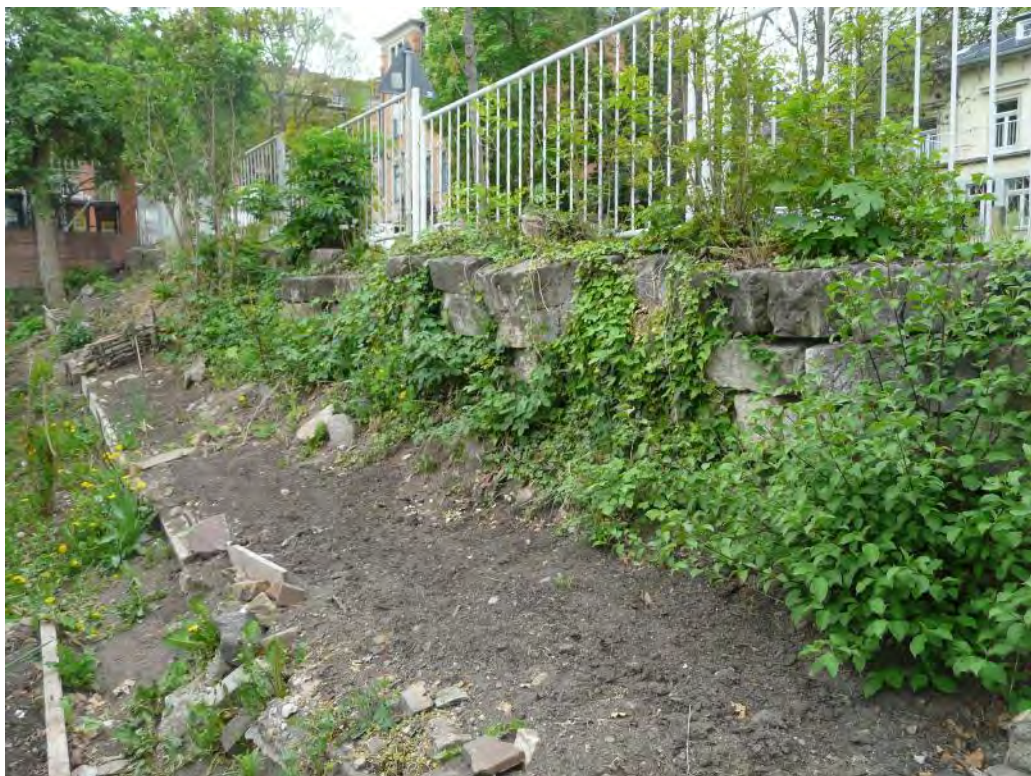
Foto 4: Stützwand ohne Betonschale im desolaten Zustand, südlicher Stützwandbereich
