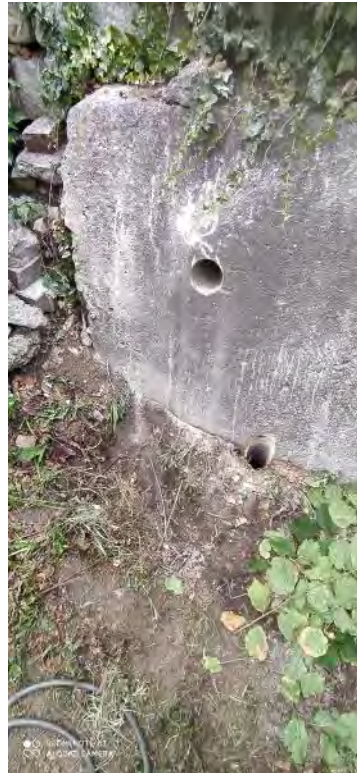
Foto 1: Kernbohrung KB 1 (oben) und KB 2 (unten) in der Stützwand mit Betonschale
