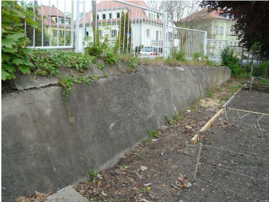
Foto 3: Stützwand mit Betonschale, nördlicher Stützwandbereich
