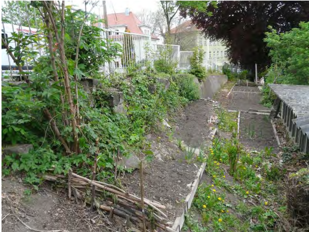
Foto 5: Böschungsbereich Blickrichtung nach Norden, in der Bildmitte ist die oberflächennahe Granitbefestigung der Böschung erkennbar.
