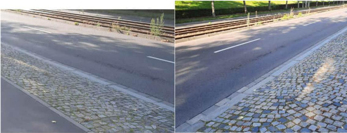
**Abbildung 13: Längsriss vermutlich infolge von Gefrierschäden (Bereich Tankstelle)**
