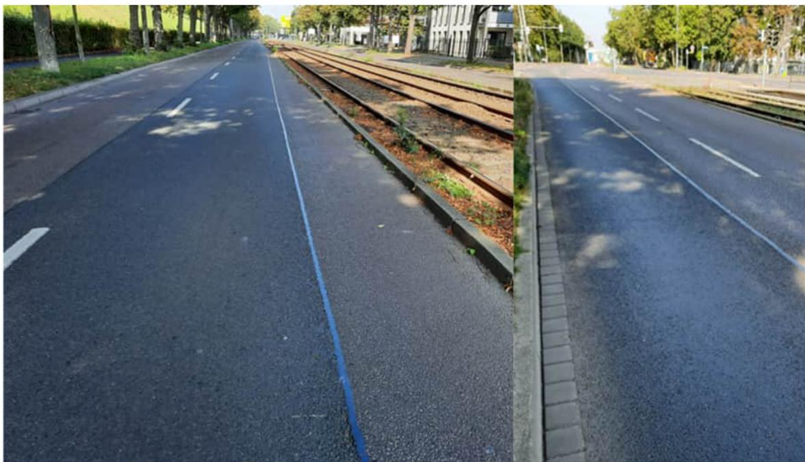
**Abbildung 15: Nachträglich eingebrachter Medienkanal**
