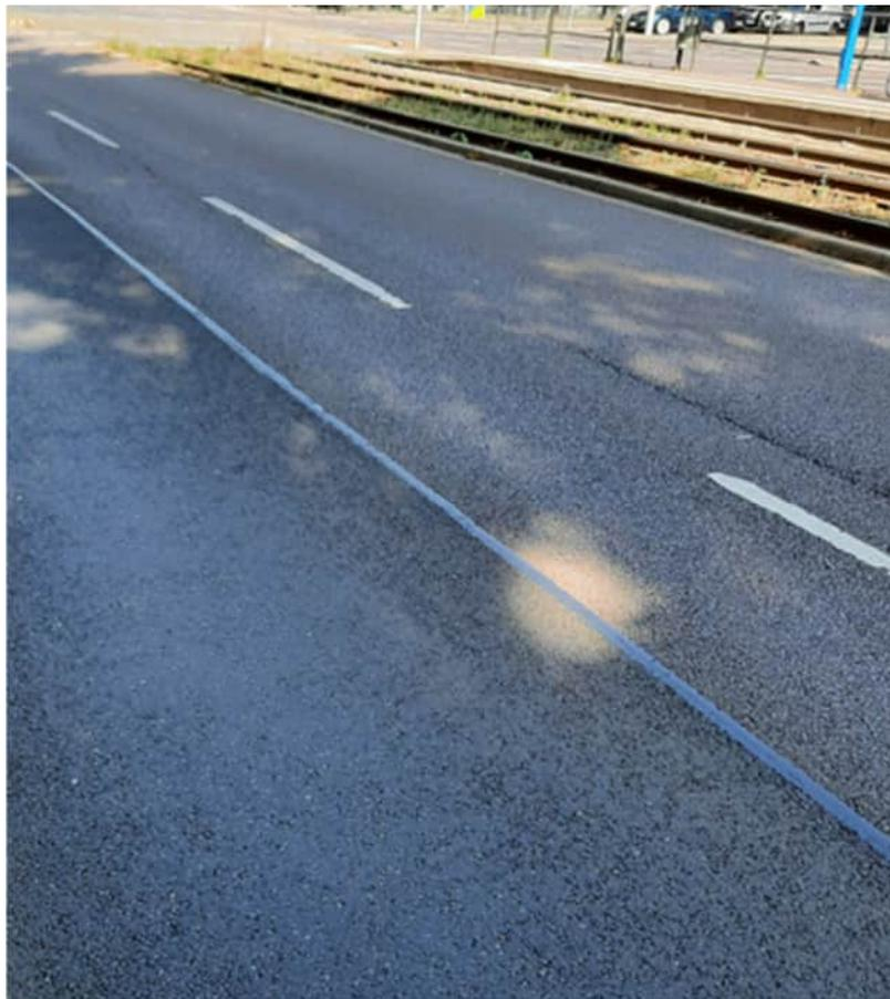
**Abbildung 14: Längsriss vermutlich infolge von Gefrierschäden**
