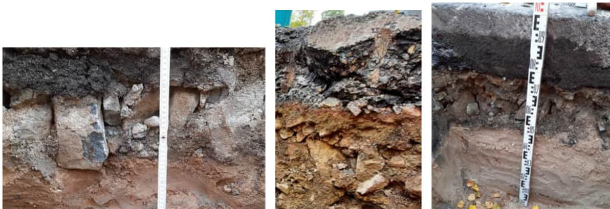
**Abbildung 16: Packlage teilweise mit F2/F3 durchsetzt**
