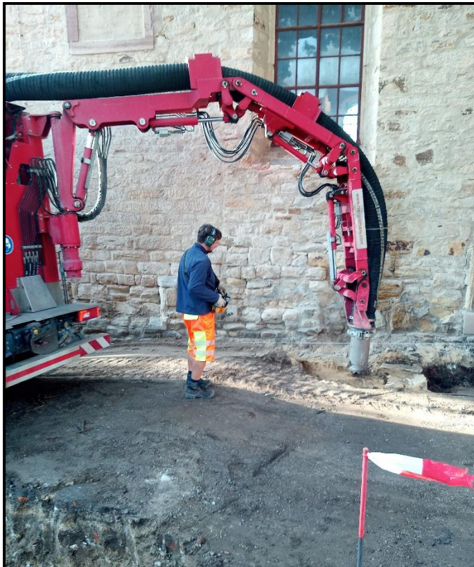
Abb. 3: Einsatz eines Saugfahrzeuges zur schonen Freilegung von Baumwurzeln (Foto: Bearbeiter).
