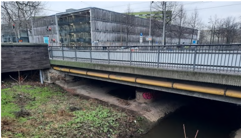
Abbildung 12: Ansicht Pfaffendorfer Brücke von Westen
