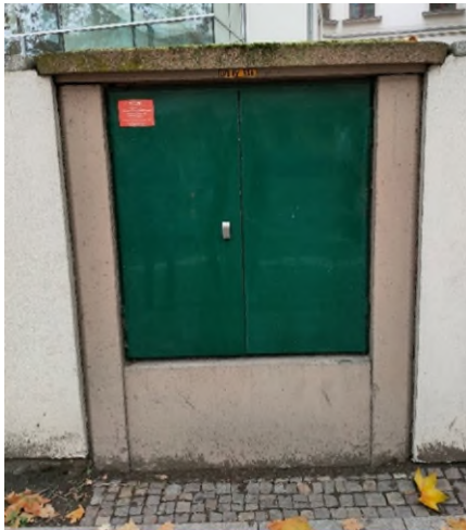
Abbildung 10: Frontansicht RV536 in der Uferstraße
