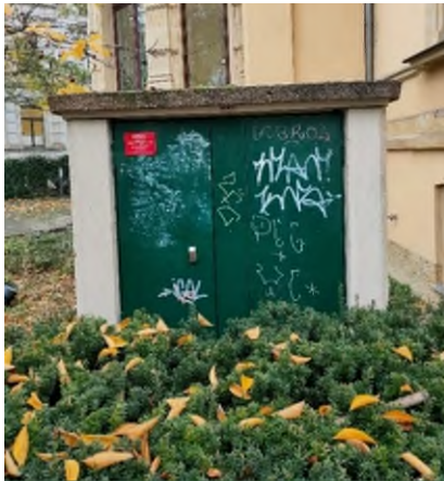
Abbildung 8: Frontansicht des KV220 an der Pfaffendorfer Straße im Bestand
