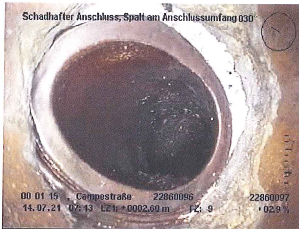
Foto 009 Videoband: X72 Zustand BAH C 2,60 m 9 Uhr Schadhafter Anschluss, Spalt am Anschlussumfang
