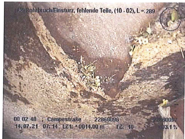
Foto 010 Videoband: X72 Zustand BAC B Anfang 14,00 m 10 - 2 Uhr Rohrbruch/Einsturz, fehlende Teile, Länge = 250mm
