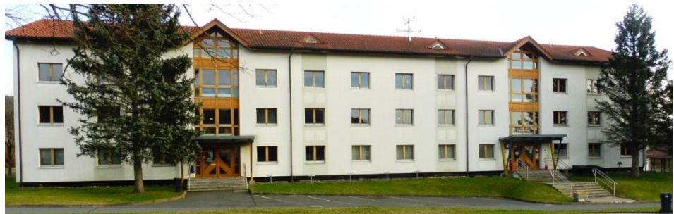
01.2 Fassade Strassenseite West
