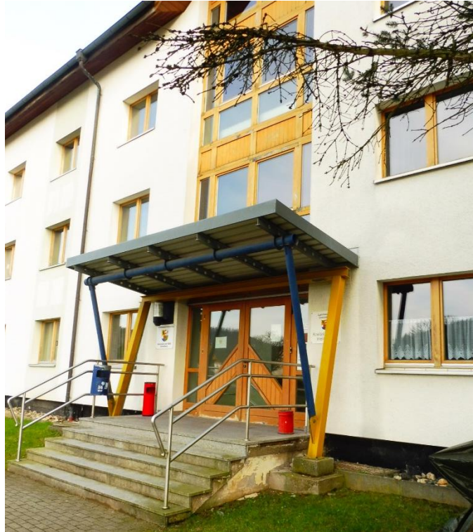
01.4 Fassade Strassenseite West-Haupteingang/Vordach
