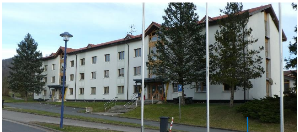
01.3 Fassade Strassenseite West
