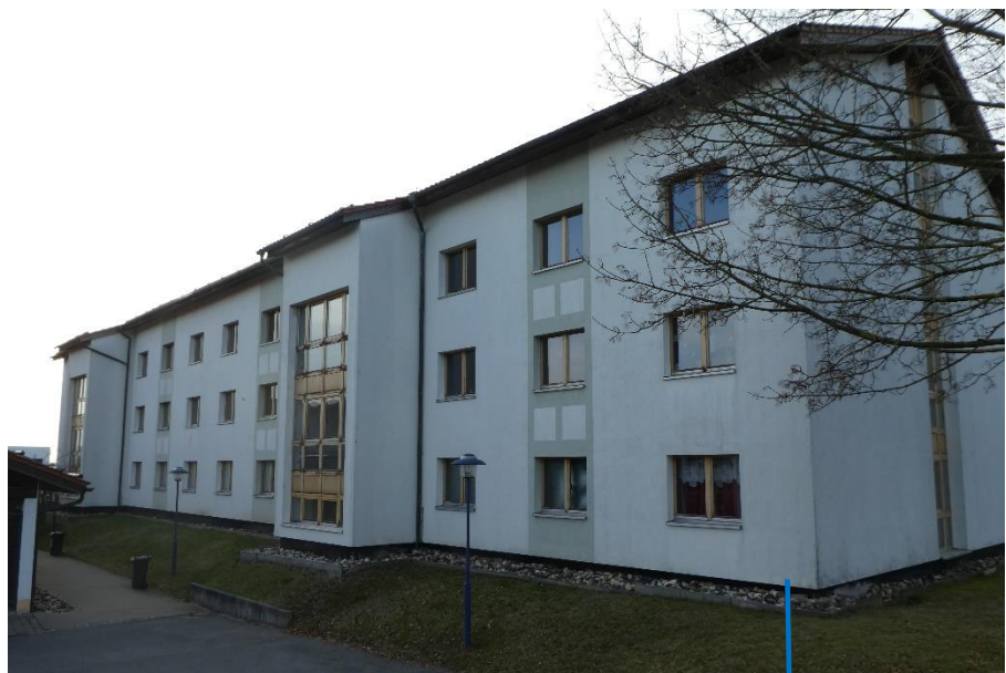
02.1 Fassade Hinterseite Ost
