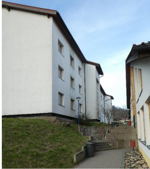
02.2 Fassade Hinterseite Ost (südlicher Teil)
