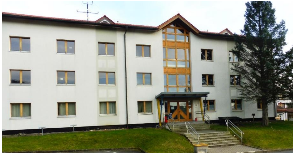
01.1 Fassade Strassenseite West
