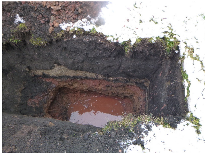
Bild 16: Baggerschürfung mit raschem Schichtenwasserzutritt
