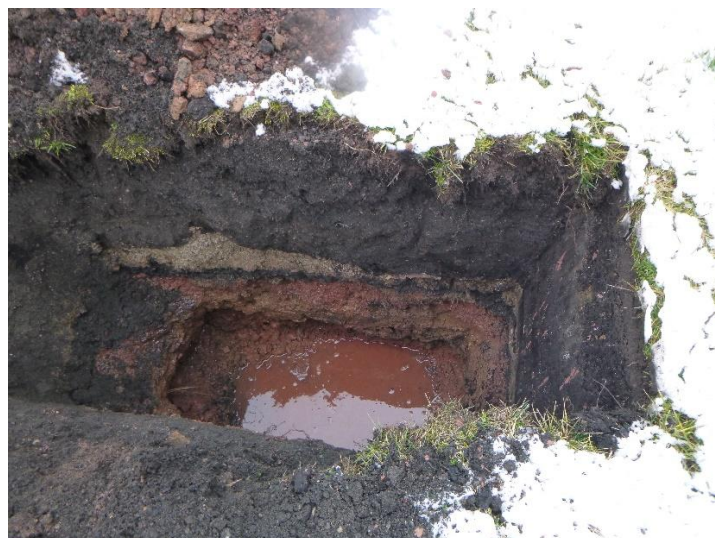
Bild 16: Baggerschürfung mit raschem Schichtenwasserzutritt
