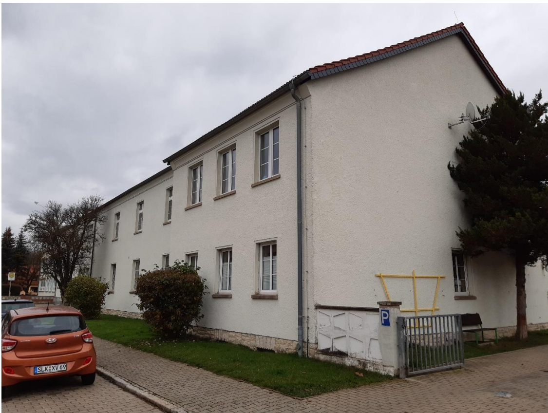
2 Hauptgebäude, Straßenseite, Ansicht aus West
