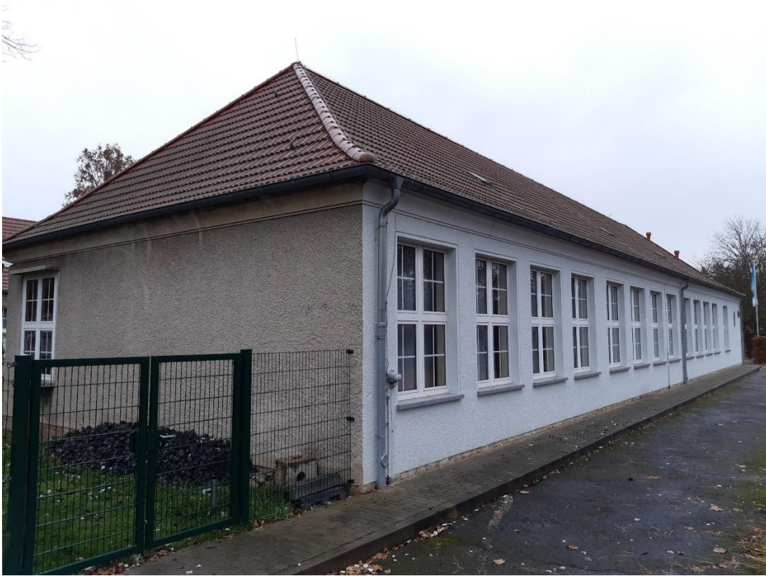
11 Quergebäude, Außenseite, Ansicht aus Süd
