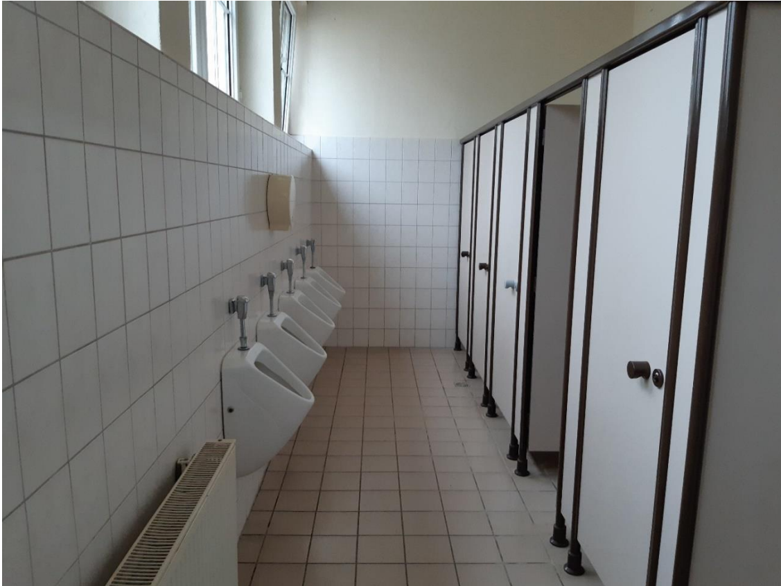
15 Langes Quergebäude, WC-Anlage
