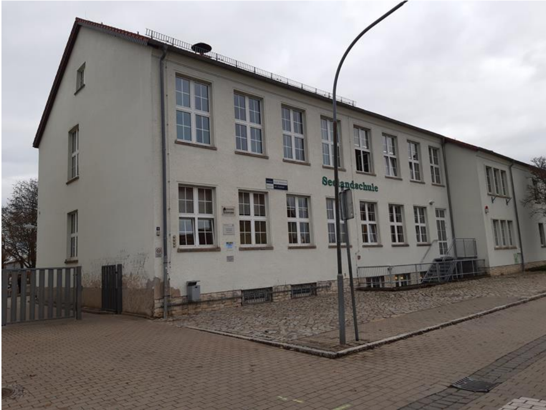
1 Hauptgebäude, Straßenseite, Ansicht aus Nord
