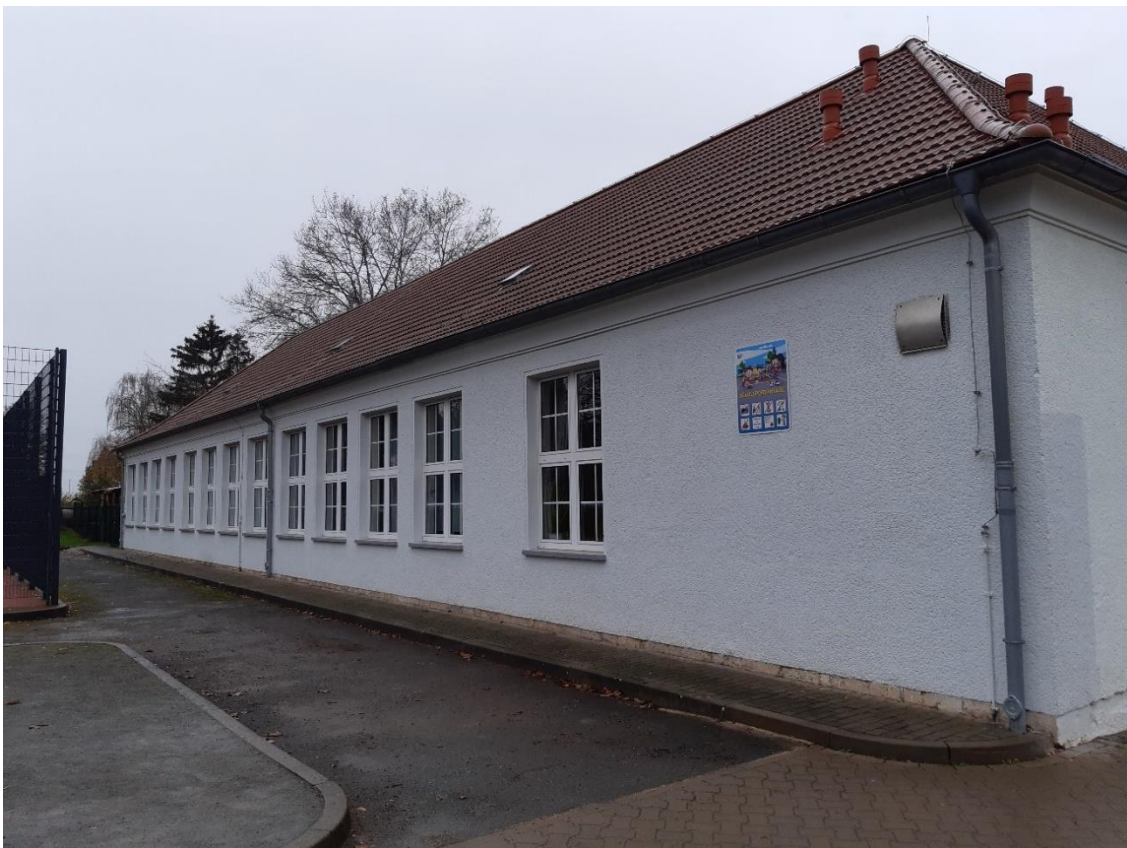
10 Quergebäude, Außenseite, Ansicht aus Süd/Ost
