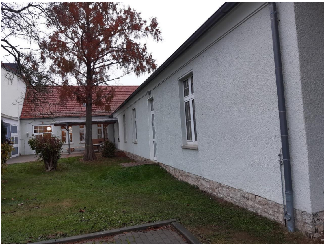
6 Querflügel, Ansicht aus West
