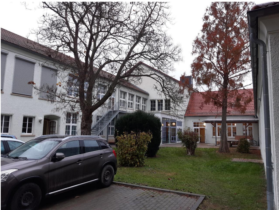
4 Hauptgebäude, Innenhofseite, Ansicht aus Süd
