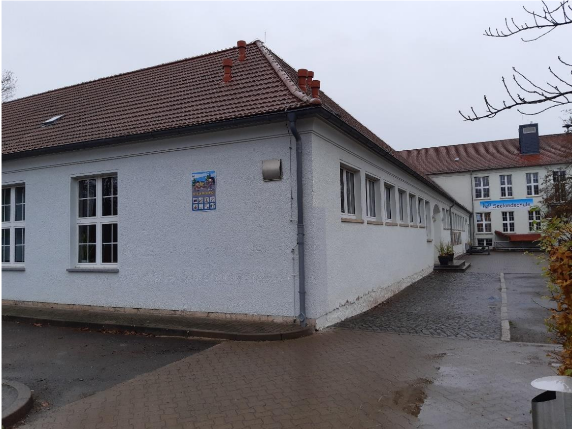
9 Langes Quergebäude, Außenseite Schulhof, Ansicht aus Ost
