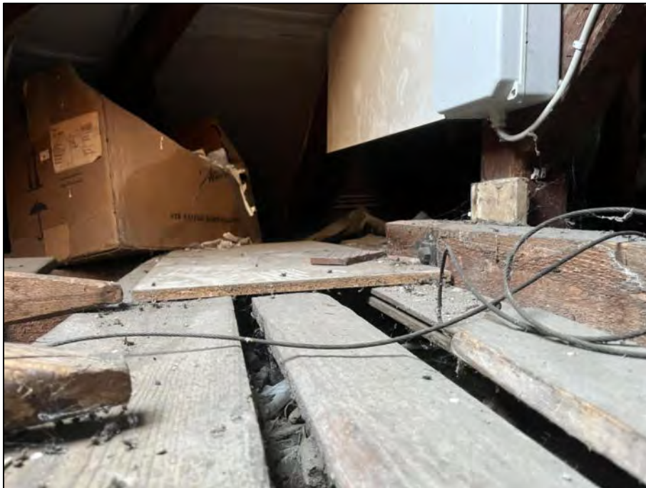
Abbildung 12: Dachboden Schulgebäude: Keine dämmende Auflage des Bodens vorhanden.
