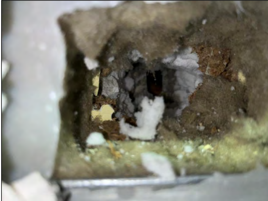
Abbildung 8: Bauteilöffnung Außenwand südliche Baracke (Öffnung erfolgte von innen). Wandaufbau bestehend aus Putz, Gipskarton, Dämmwolle, Holzplatte, Styropor, Faserzementplatte und Holzverkleidung.
