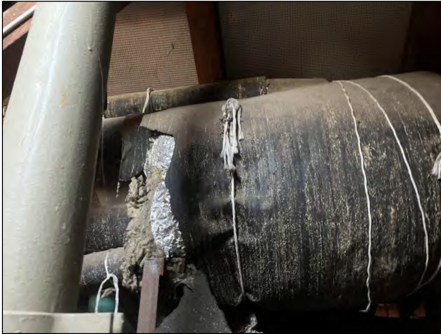
Abbildung 11: Dachboden Schulgebäude: Heizanlage mit Dämmwolle isoliert und mit Teerpappe ummantelt.
