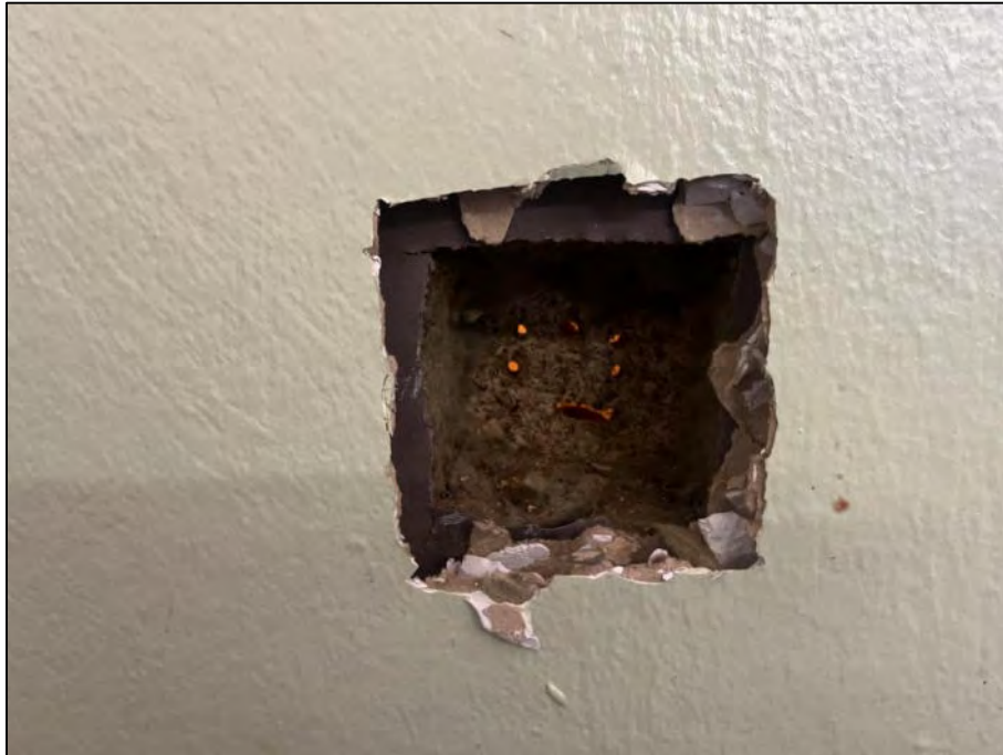
Abbildung 9: Bauteilöffnung Außenwand nördliche Baracke (Öffnung erfolgte von innen). Wandaufbau bestehend aus Putz, Gipskarton, Kunststofffolie, Dämmwolle, HWL-Dämmung und Kunststoffverkleidung
