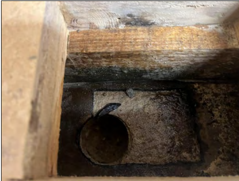
Abbildung 1: Bauteilöffnung mit Kernbohrung im Fußboden des Sportraumes (Anbau Schulgebäude). Unterhalb von zwei Schichten Spanplatten befindet sich eine Bitumenbahn sowie Beton.
