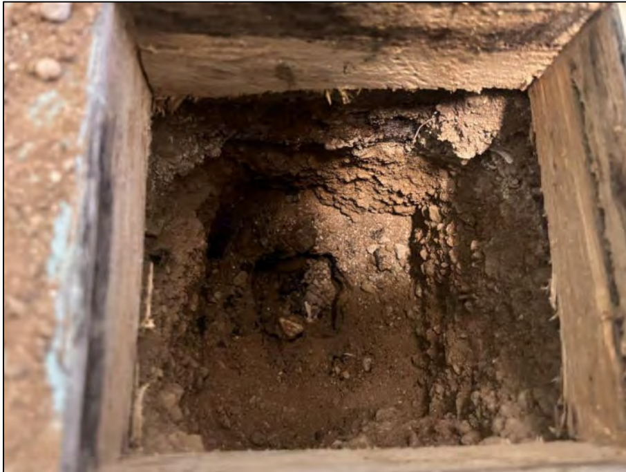
Abbildung 3: Bauteilöffnung im Fußboden des Raums 01 (Erdgeschoss, Schulgebäude). Unterhalb von zwei Schichten Spanplatten befindet sich eine Schüttung (Sand-Kies-Gemisch) sowie Bitumenbahn.
