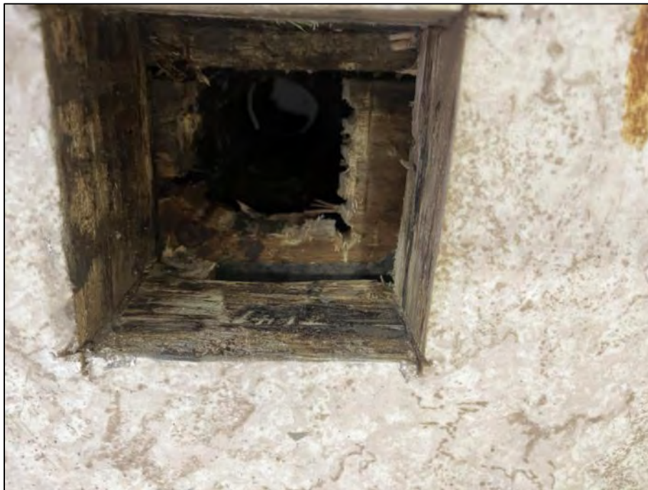
Abbildung 6: Bauteilöffnung mit Kernbohrung im Fußboden der südlichen Baracke. Unterhalb von mehreren Schichten Spanplatten / Holzdielen befindet sich eine Sperrschicht sowie Beton.
