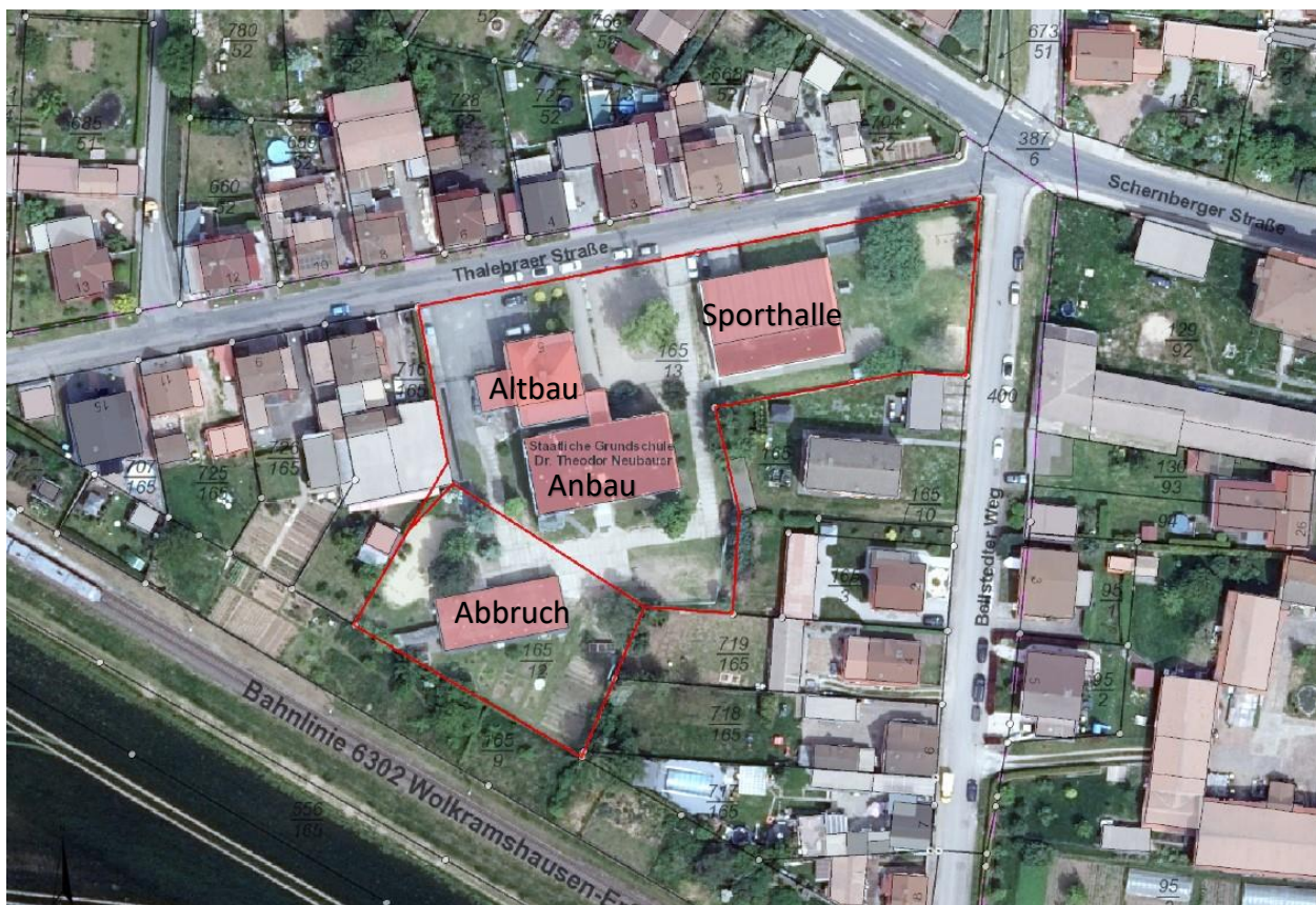
Abbildung 1, Luftbild Hohenebra, Grundstück Grundschule Hohenebra
