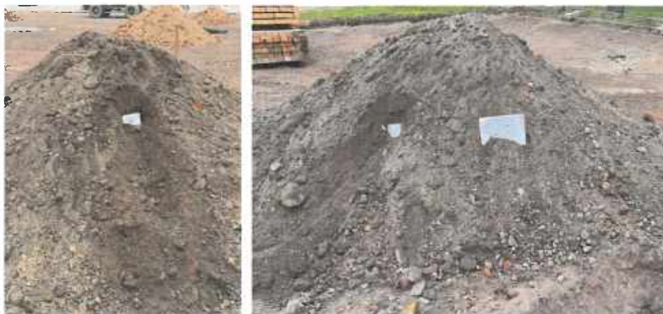
Abbildung 42 Entnahmestellen EP 21 und EP 22 aus Bodenaushub Schurf C-1
