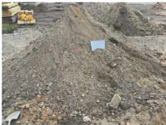
Abbildung 6 Erdaushub aus Schurf A-1
