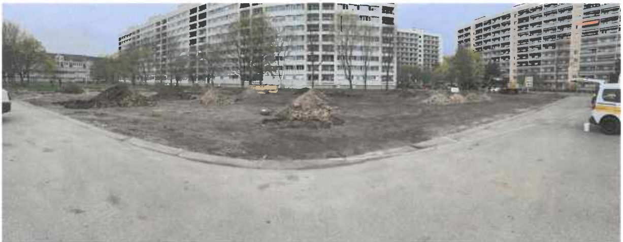
Abbildung 3 Panoramaaufnahme des Baugeländes. Freilegung der Schürfe durch Baufirma mittels Bagger.
