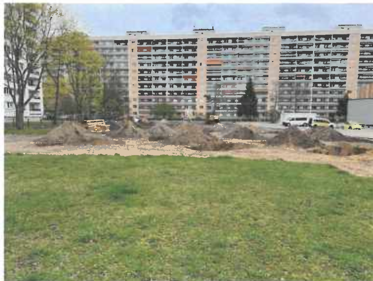
Abbildung 4 freigelegte Schürfe im Rasterfeld A und B.
