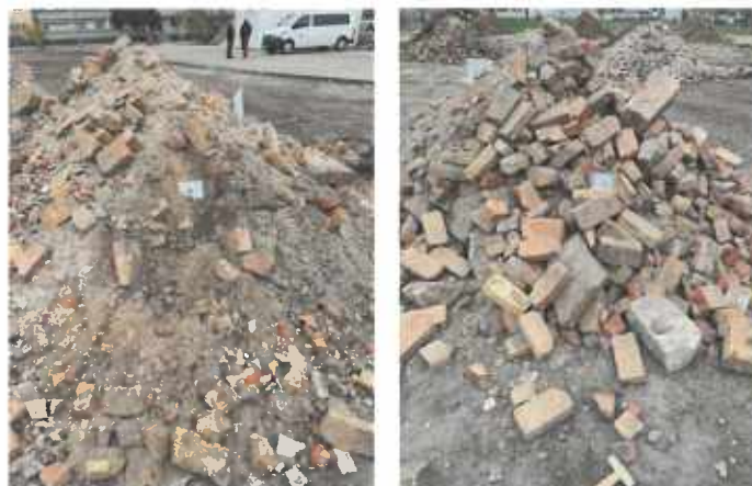
Abbildung 30 Entnahmestellen EP 15 und EP 16 aus Bodenaushub Schurf B-3
