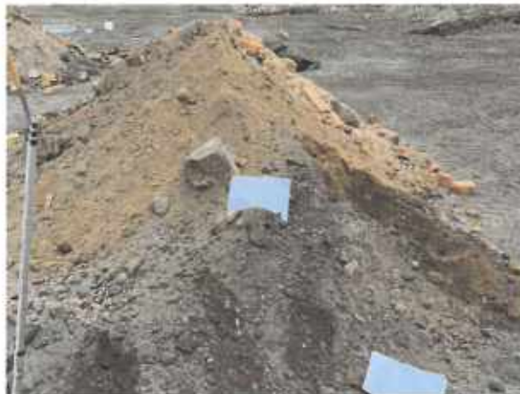
Abbildung 64 Bodenaushub aus Schurf D-2
