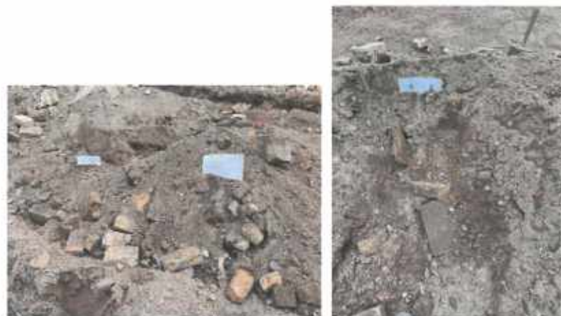
Abbildung 57 Entnahmestellen EP 31 und EP 32 aus Bodenaushub Schurf C-6
