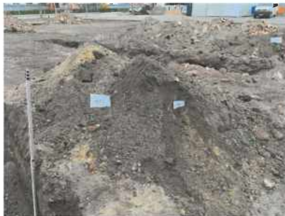
Abbildung 44 Bodenaushub aus Schurf C-2
