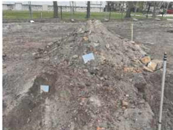
Abbildung 47 Bodenaushub aus Schurf C-3
