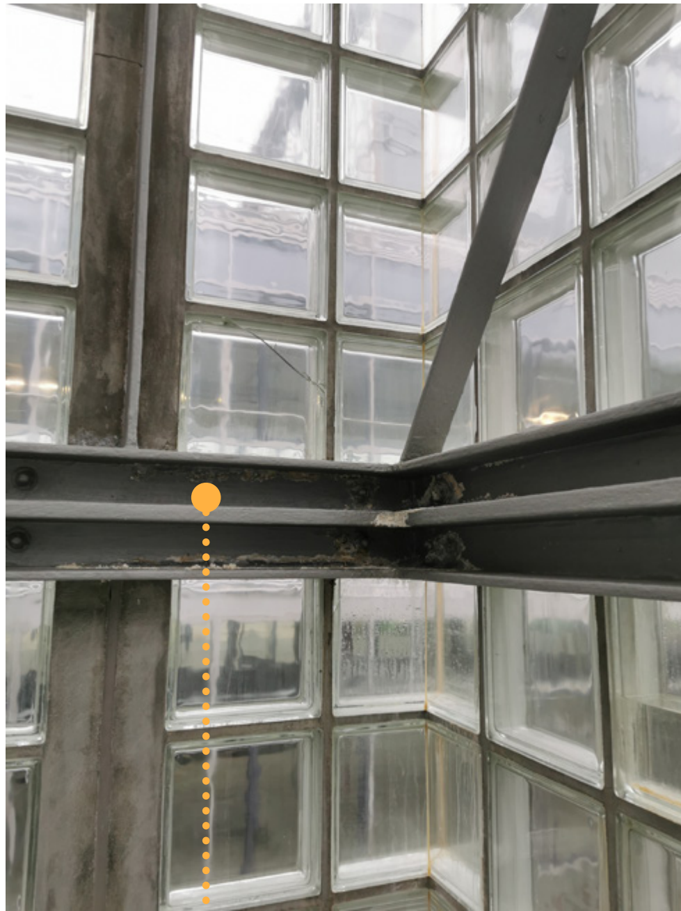
• Treppenhaus 4 und 5 • Überholung Beschichtung mit Epoxidharzfarbe
