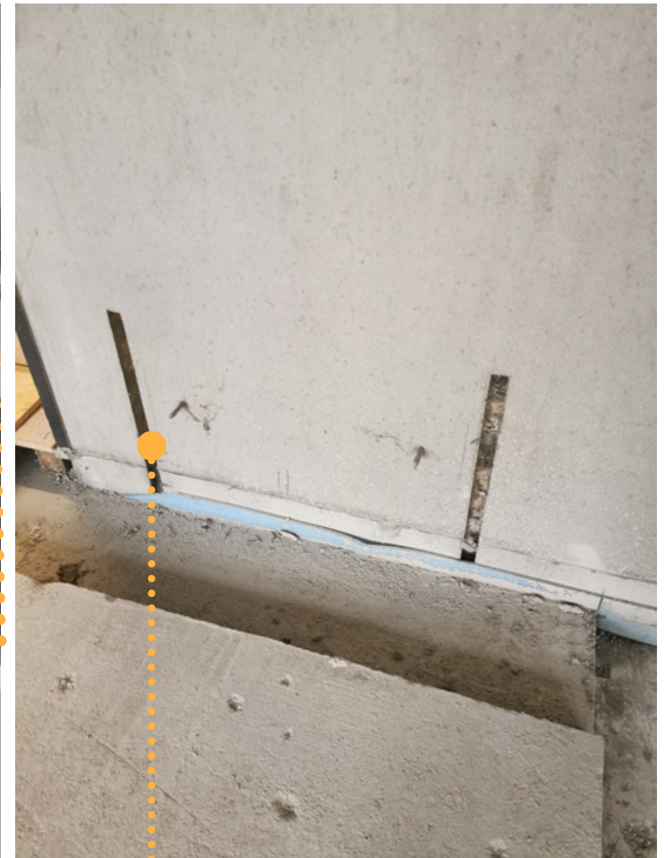
• Riegel 6 Wand • Schließen der Wandschlitze; Reparaturmörtel
