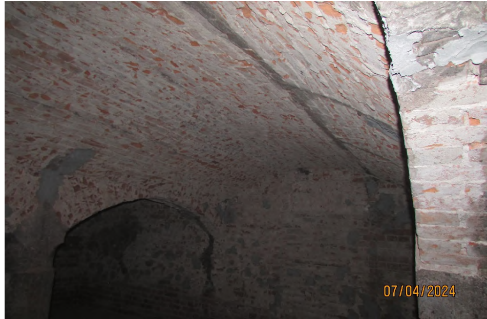
Deckenuntersicht Keller- gewölbe, Putz komplett entfernt
