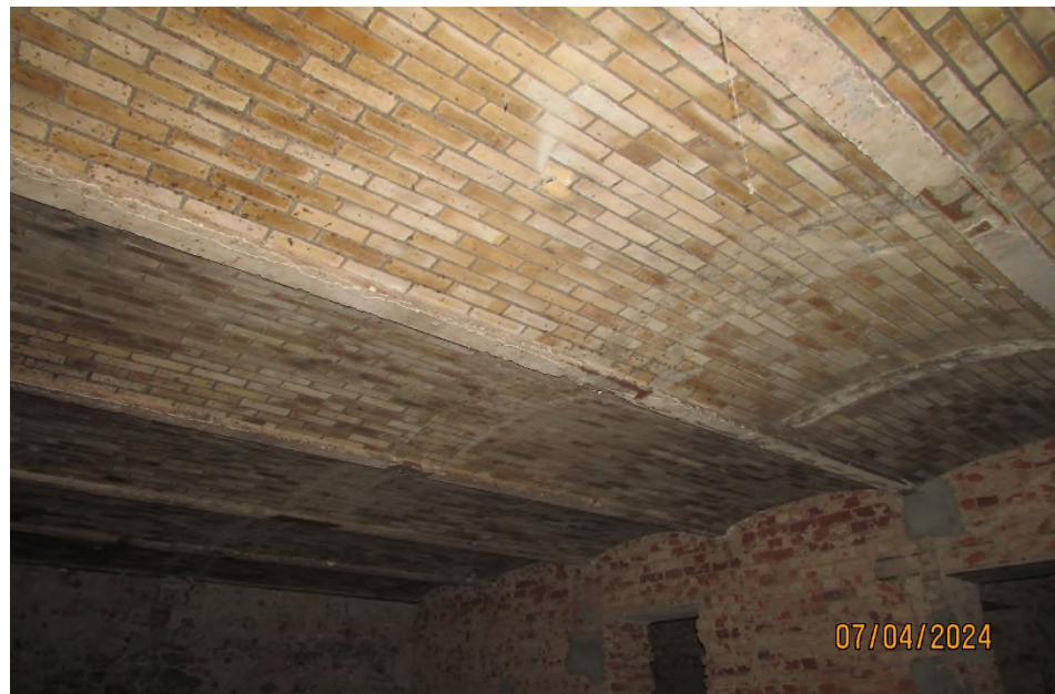
Deckenuntersicht Kap- pendecke mit Stahlträ- ger, Ziegeloberfläche la- siert
