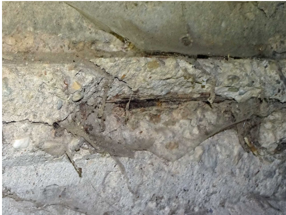
S15 FREILIEGENDE BEWEHRUNG AN WDL HINTEN
