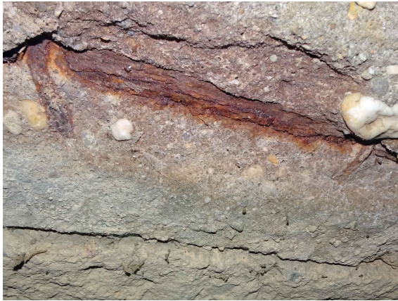
S26 FREILIEGENDE BEWEHRUNG MIT QUERSCHNITTMINDERUNG
