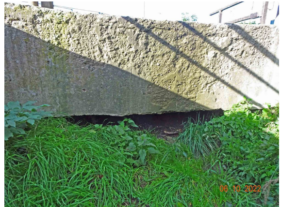
S11 STÜTZWAND UNTERS PÜLT VORN
