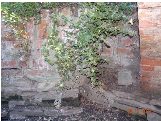
S13 STÜTZWAND AUSGEBACHT
