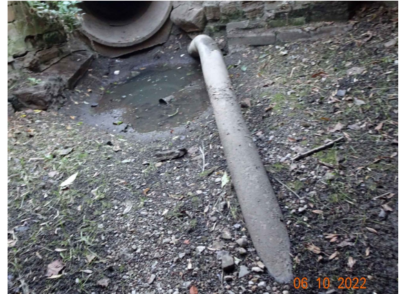
S32 SCHUTZROHR FREILIEGEND
