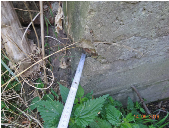
S23 ABPLATZUNG MIT QUERRISS HINTEN LINKS
