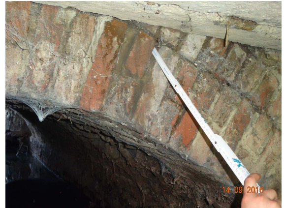
S20 NASSE MAUERWERKSFUGEN
