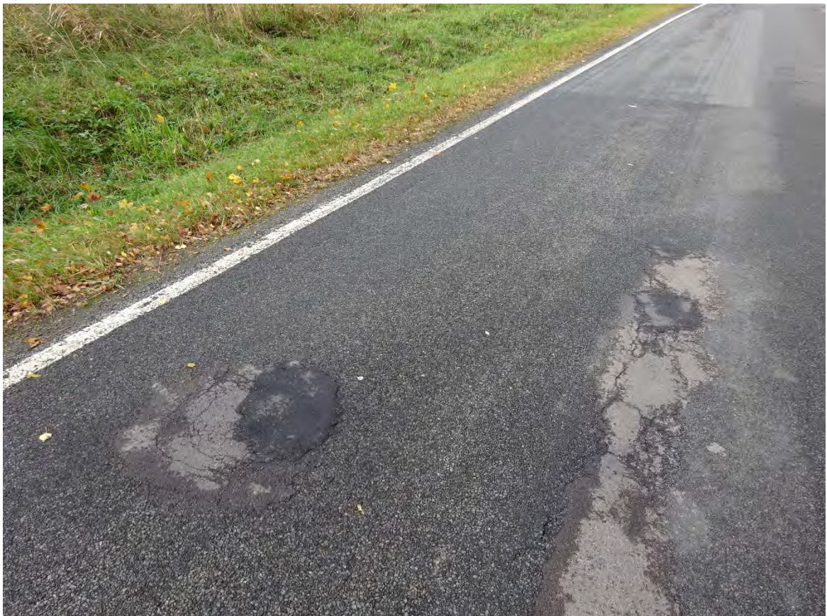
km 2+028: Ausbesserungen, Kornausbrüche und OB links
