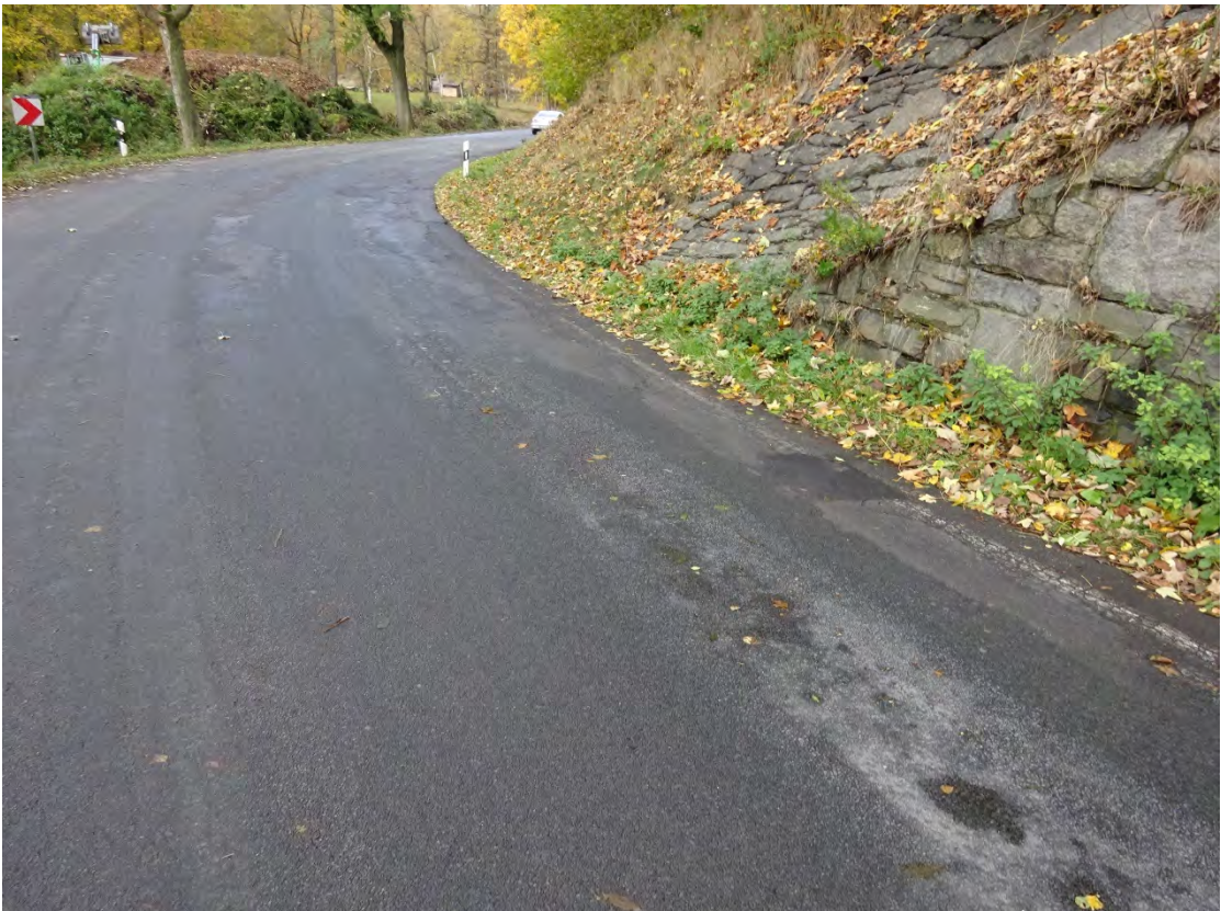
km 1+270: Ansicht rechts; Ausbesserungen, Oberflächenbehandlung (OB)
