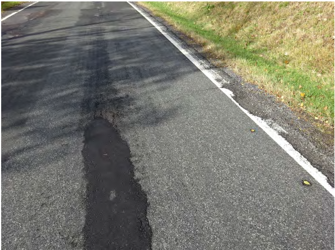
km 1+839: OB, Ausbesserungen, Kantenabbrüche rechts
