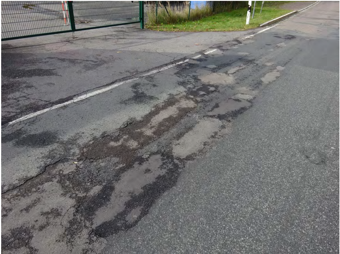
km 2+190: Kornausbrüche, Aufbrüche und Ausbesserungen, OB links
