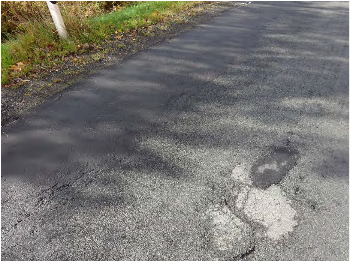
km 1+839: OB, Kornausbrüche und Ausbesserungen links
