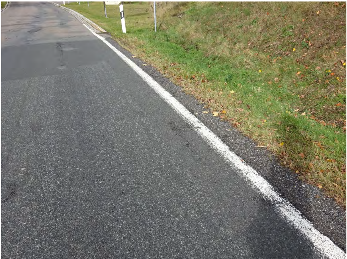
km 2+190: Kornausbrüche in OB rechts, Kantenabbrüche
