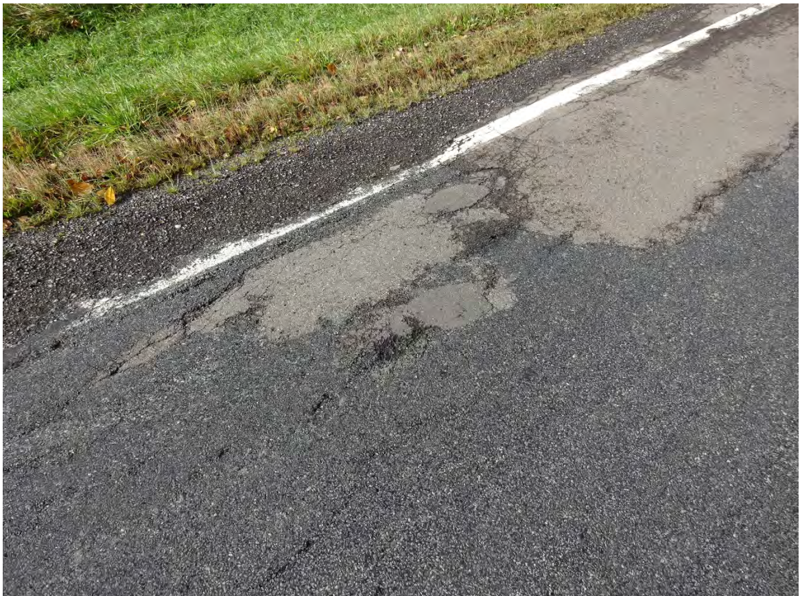
km 1+618: Kornausbrüche und Substanzverlust links, OB, Ausbesserungen
