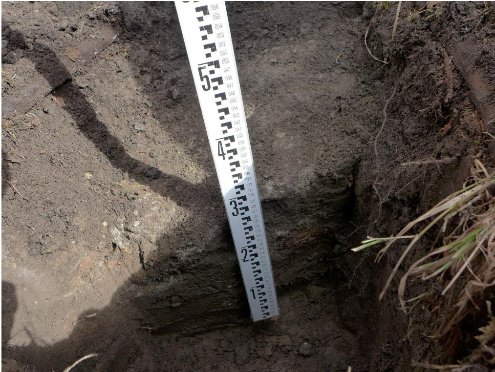
Bild 5: Unterbeton der Stützmauer, Überstand: 50 cm , Stärke: 45 cm (s. Anlage 3)
