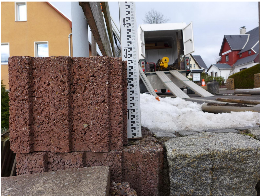
Bild 4: Stützwandkopf Betonpflanzstein (40 x 30 x 25 cm)
