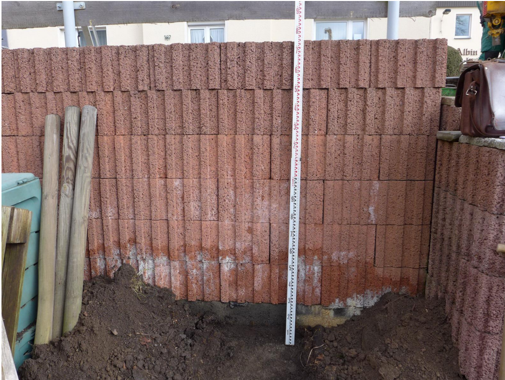
Bild 3: Stützmauer, freigelegte Stützmauer auf 25 cm hohem Betonfundament
