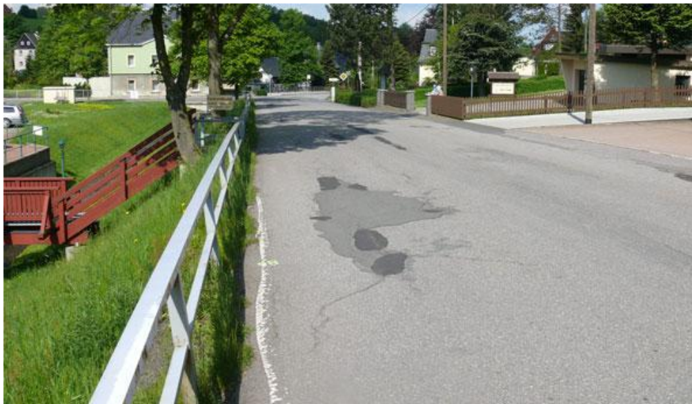
Abbildung 2: Deformationen an Fahrbahn und Geländer
