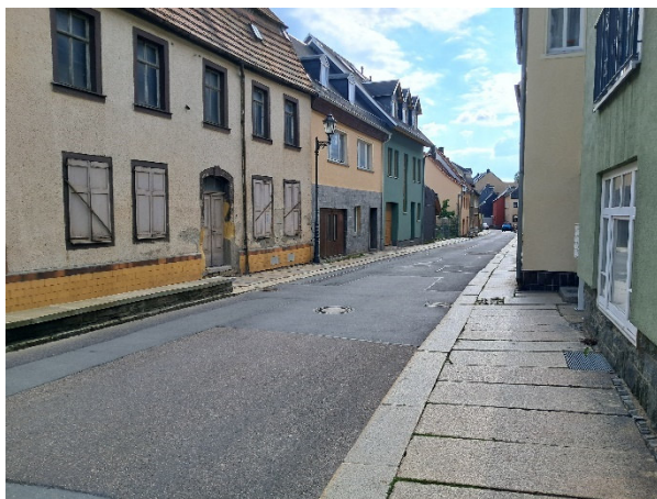
Abb.: Bauanfang, Blickrichtung Südwest;
