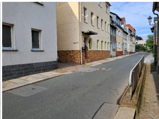
Bauende, Blickrichtung Nordost
