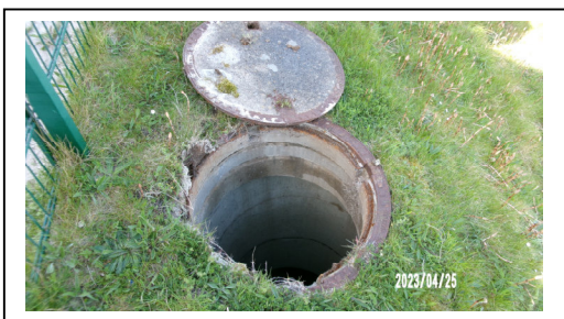
Bild 29: Schacht der Entwässerung
