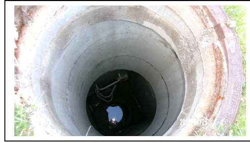
Bild 30: Schacht der Entwässerung
