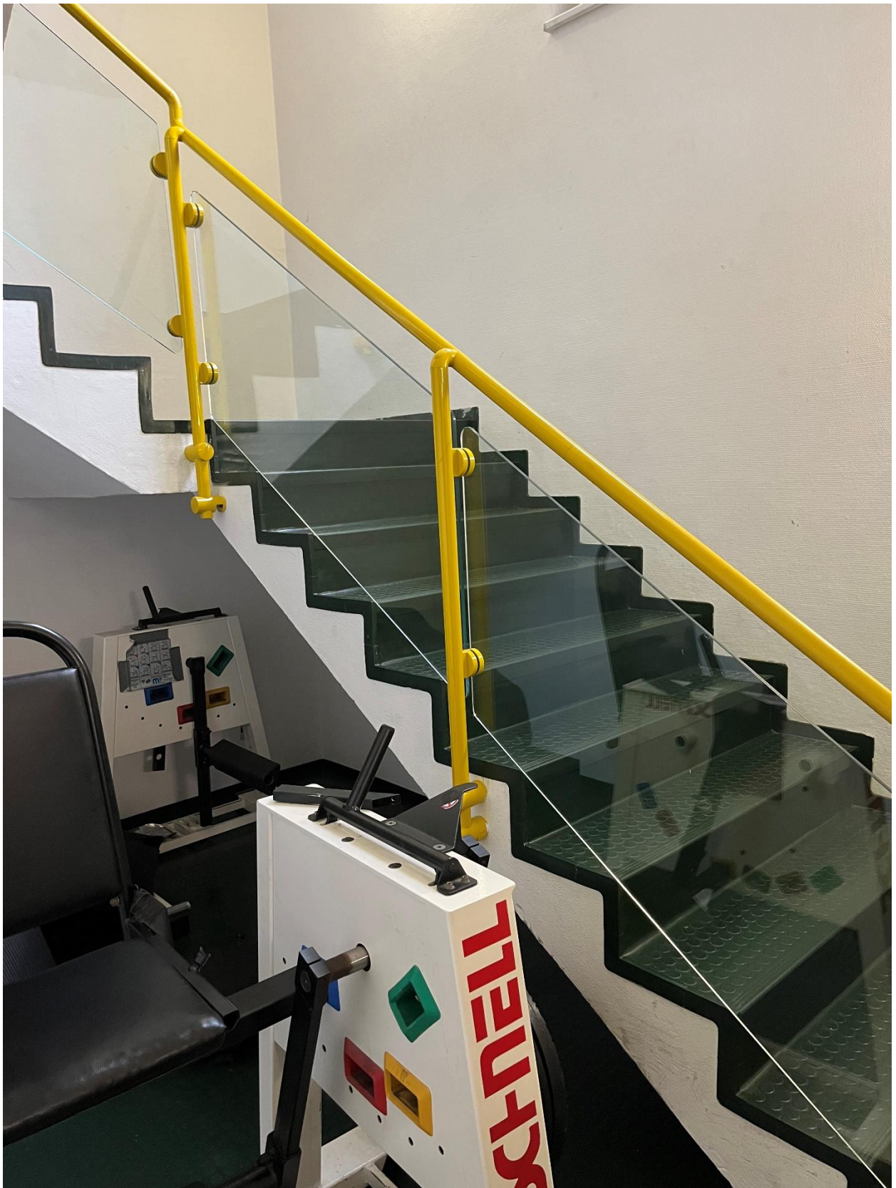
Bild 13: Treppe Flur 01.090c
