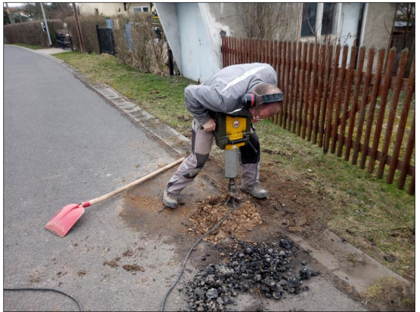
Bild 16: Lagenweise verdichteter Einbau der Aushubmassen zum Wiederverschluss des Schurfes S 1/24, Foto: GIAB, 21.02.2024
