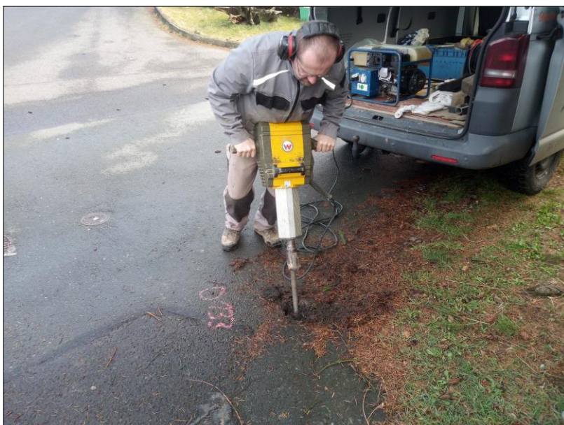
Bild 3: Aufbruch des Asphalttes mittels Spitzmeißel für die RKS 8/24, Foto: GIAB, 20.02.2024
