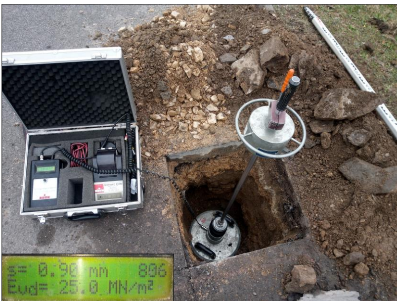
Bild 15: Verdichtungsnachweis des Planums mittels dynamischem Plattendruckversuch sowie ermitteltem Verformungsmodul E_{vd} , Foto: GIAB, 21.02.2024
