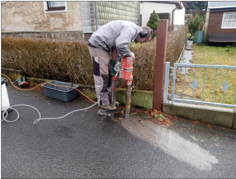
Bild 7: Durchörterung des Asphalttes mittels Diamantkernbohrung für die RKS 10/24, Foto: GIAB, 19.02.2024
