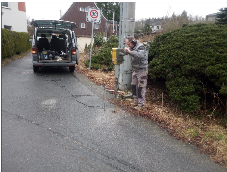
Bild 1: Abteufen der RKS 3/24 im Bereich zwischen der Dorfstraße 22 und 24, Foto: GIAB 20.02.2024
