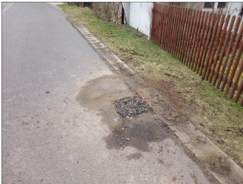
Bild 16: Lagenweise verdichteter Einbau der Aushubmassen zum Wiederverschluss des Schurfes S 1/24, Foto: GIAB, 21.02.2024
