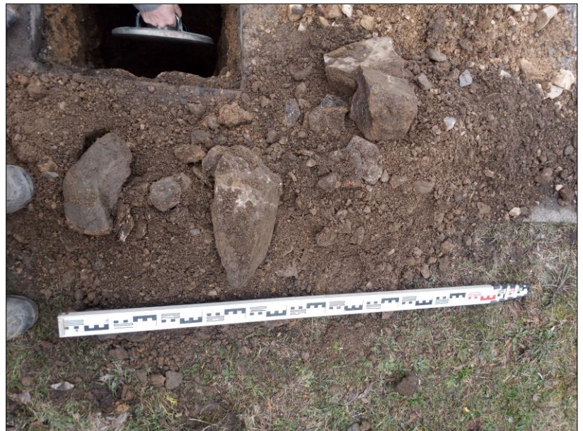
Bild 14: Aushub aus dem Schurftiefsten mit Steinen und Blöcken mit Kantenlängen >20cm, Foto: GIAB, 21.02.2024
