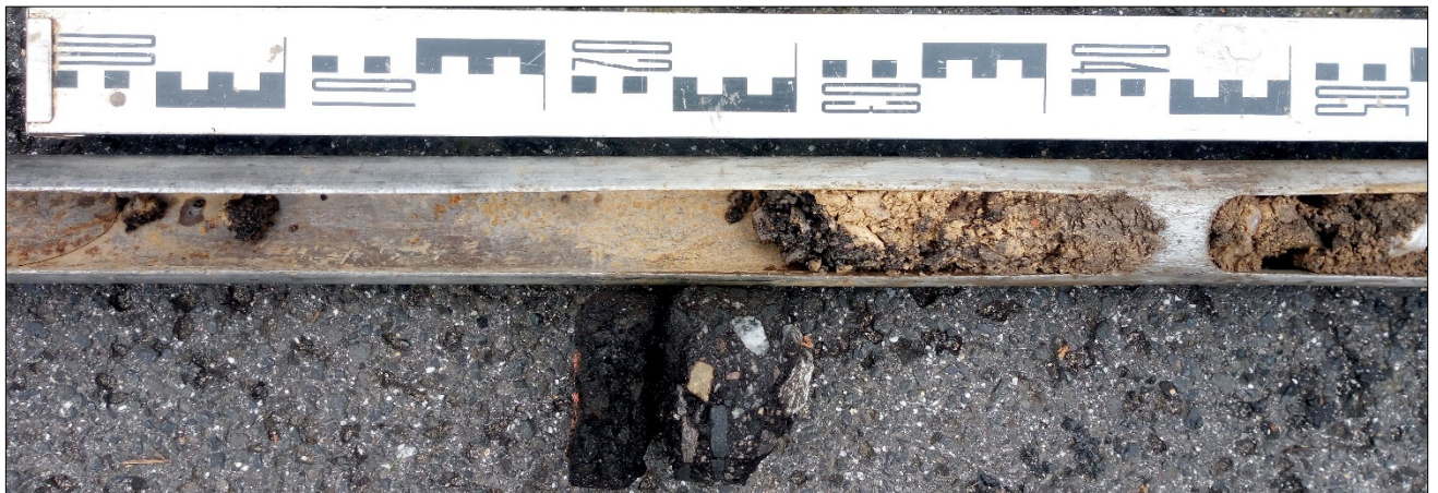
Bild 7: Sondeninhalt der RKS 10/24 mit Asphalt und künstlicher Auffüllung (0,00 m - 0,50 m), der Asphalt wurde aufgebrochen und separat gewonnen, Foto: GIAB 20.02.2024
