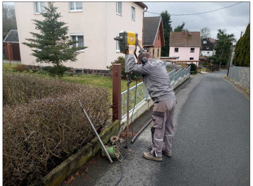
Bild 3: Abteufen der RKS 9/24 im Bereich der Straße „Hüttensteig 44“ Foto: GIAB 20.02.2024
