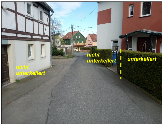
Bild 17: Übersichtsaufnahme des kritischen Bereiches der Dorfstraße 24 und Dorfstraße 26 mit Darstellung des Unterkellerten Bereiches, Foto: GIAB 21.02.2024
