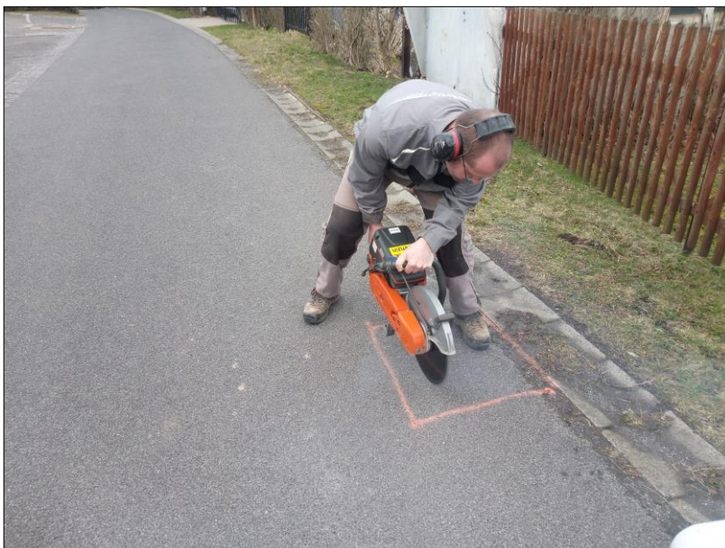
Bild 9: Auftrennen der Asphaltfläche für den Schurf S 1/24, Foto: GIAB, 21.02.2024
