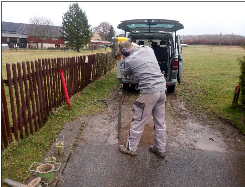
Bild 6: Abteufen der RKS 12/24 innerhalb Bereich der Straße „Hüttensteig 60“, Foto: GIAB 19.02.2024
