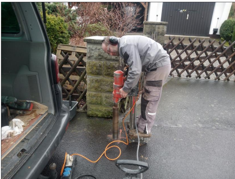
Bild 5: Durchörterung des Asphaltes mittels Diamantkernbohrung für die RKS 9/24, Foto: GIAB, 19.02.2024
