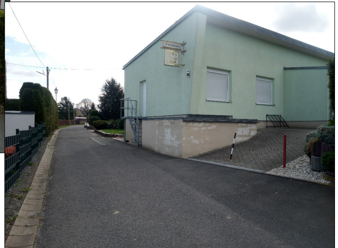
Bild 18: Übersichtsaufnahme des kritischen Bereiches am Bürgerhaus auf der Straße „Hüttensteig“, Foto: GIAB 21.02.2024
