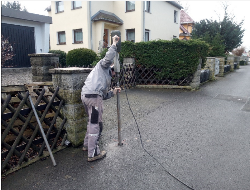
Bild 3: Abteufen der RKS 9/24 im Bereich der Straße „Hüttensteig 44“ Foto: GIAB 20.02.2024
