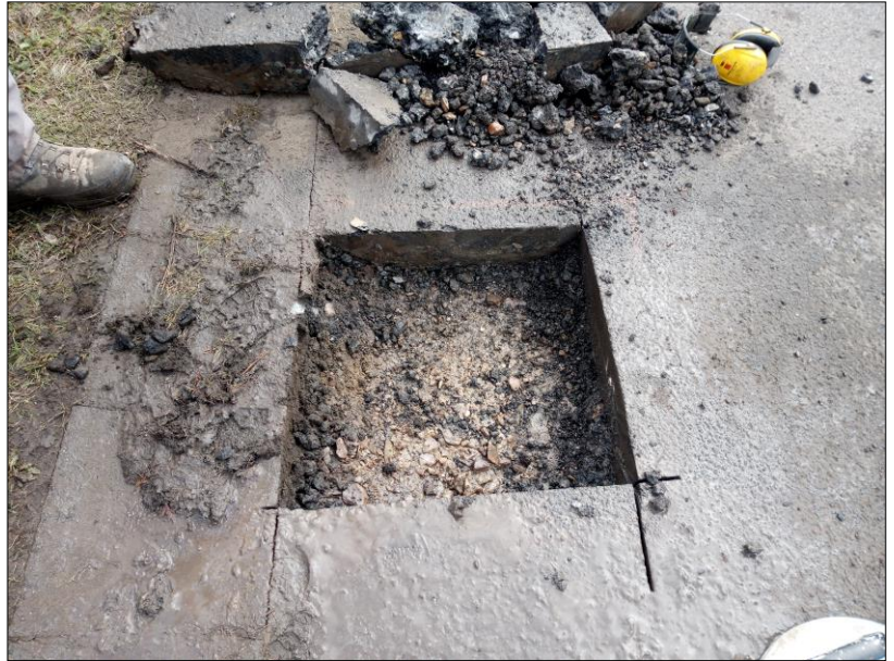
Bild 10: Geöffneter Asphalt des Schurfes S 1/24 mit darunter befindlichem Frostschutz, Foto: GIAB, 21.02.2024
