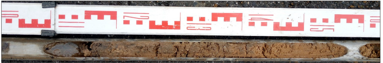
Bild 9: Sondeninhalt der RKS 10/24 mit künstlicher Auffüllung und Übergang zum Verwitterungslehm (1,00 m - 1,50 m), Foto: GIAB 20.02.2024
