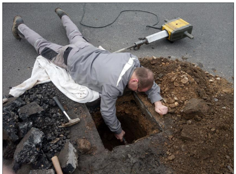
Bild 12: Vertiefung des Schurfes bis auf Planumsniveau, Foto: GIAB, 21.02.2024
