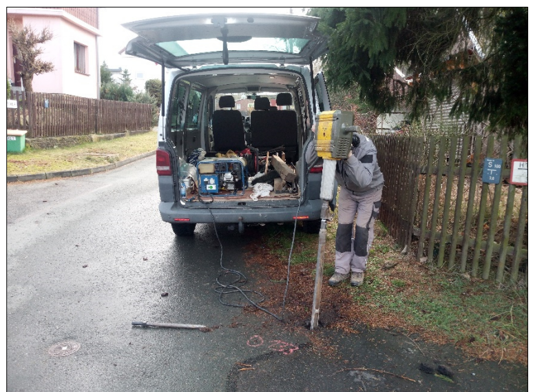
Bild 2: Abteufen der RKS 8/24 im Kreuzungsbereich Dorfstraße / Hüttensteig, Foto: GIAB 20.02.2024
