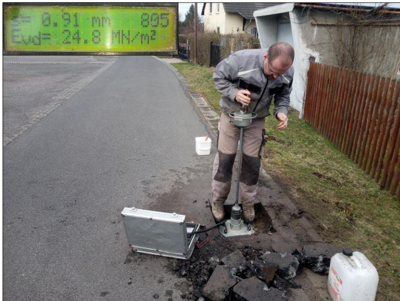
Bild 11: Verdichtungsnachweis des Frostschutzes mittels dynamischem Plattendruckversuch sowie ermitteltem Verformungsmodul E_{vd} , Foto: GIAB, 21.02.2024
