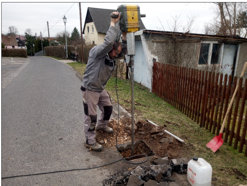
Bild 5: Abteufen der RKS 11/24 innerhalb des Schurfes S 1/24 im Bereich der Straße „Hüttensteig 56“, Foto: GIAB 21.02.2024
