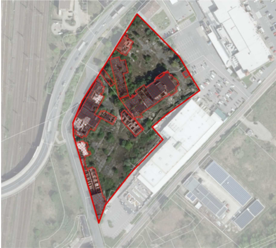
Abbildung 3: Bestehende Gebäude auf dem Grundstück
