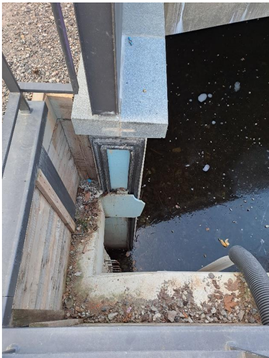
Foto Nr. 27: Anschlussfuge Elsterbrücke rechte Uferseite und bauzeitliche Geländeabfangung mit temp. Kopfbalken und Geländer
