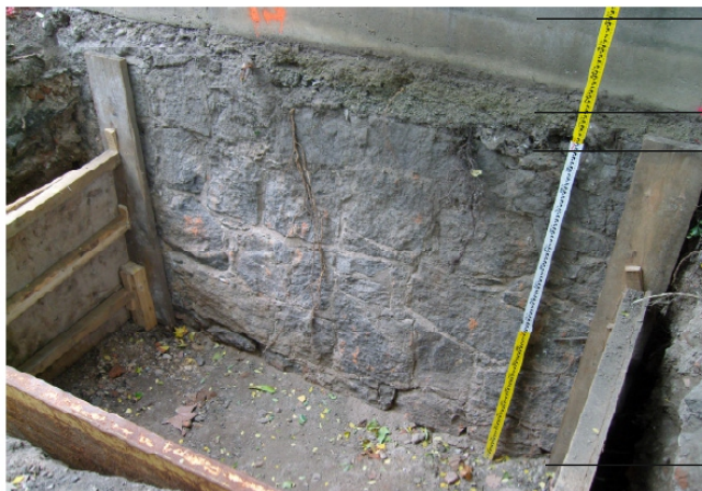
S 4-08 (linke Ufermauer, Granit/Porphyr)
