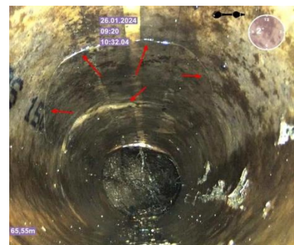
Abbildung 6: Schadhafter Inliner
