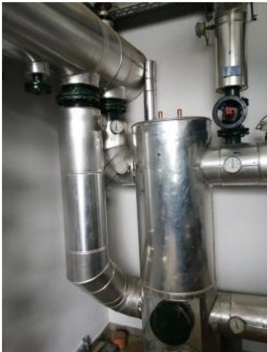
Auszubauender Schornstein DN 300 mit gedämmter Verblechung DN 500
