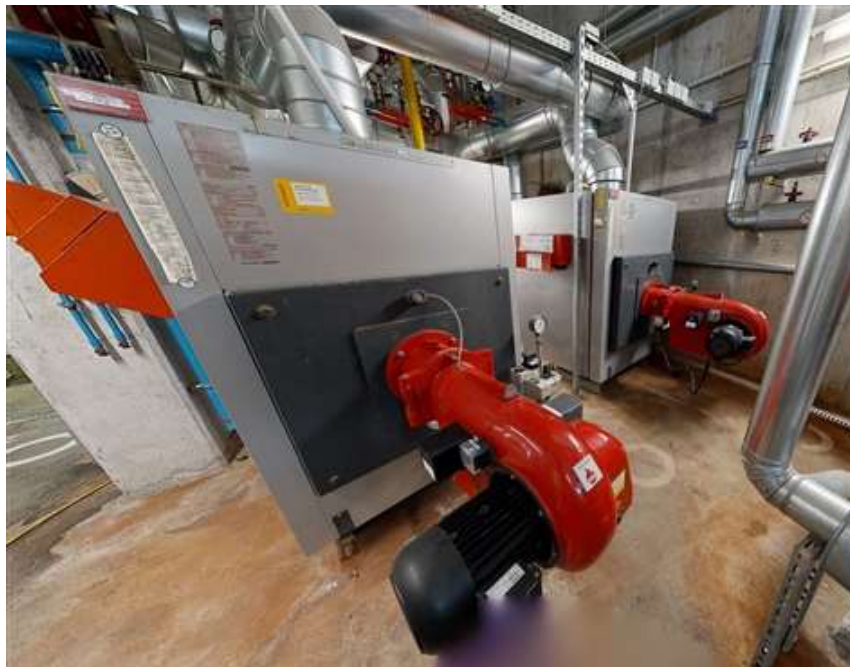
Bild 1: Gaskessel, Bestand
