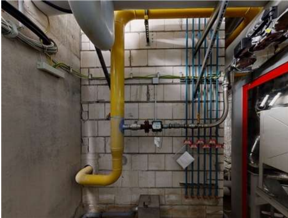
Bild 1: Gasanschluss, Technikraum
