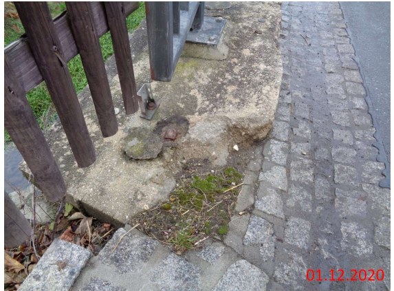
2020E_030_KAPPENBETON AUSGEBROCHEN
