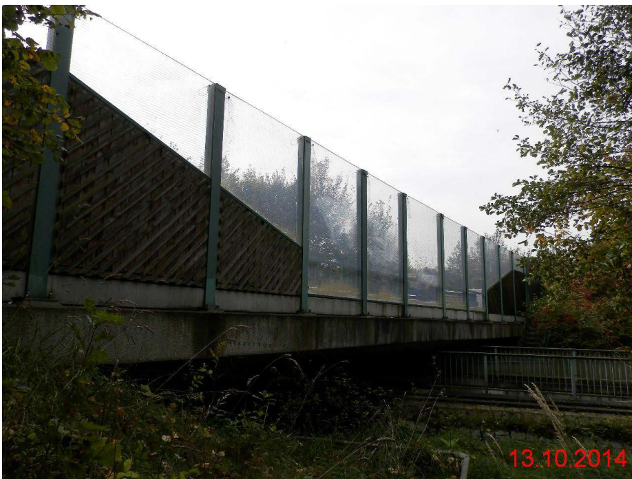
02_Übersicht Baubereich Anliegerseite
