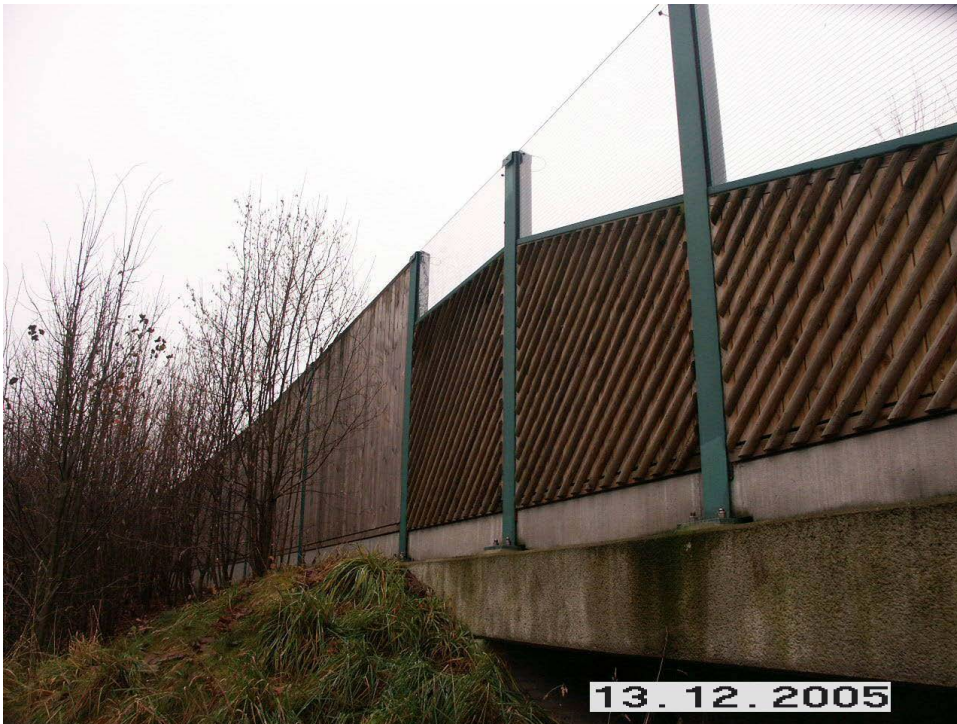
03_ Detail Baubereich Anliegerseite
