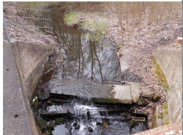
Ansicht in Richtung Oberstrom mit Staustufe
