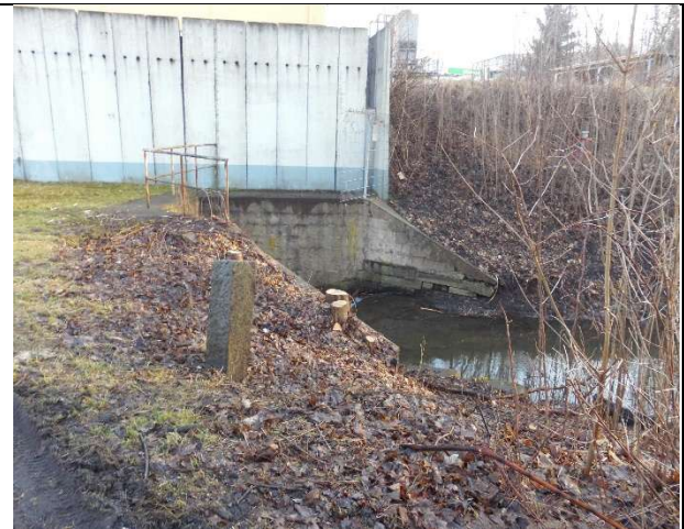
Einfriedung Werksgelände von außen gesehen
