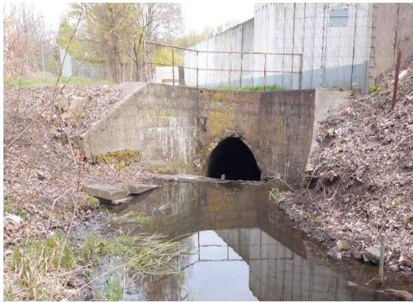
Ansicht Portal oberstrom, ohne Bewuchs
