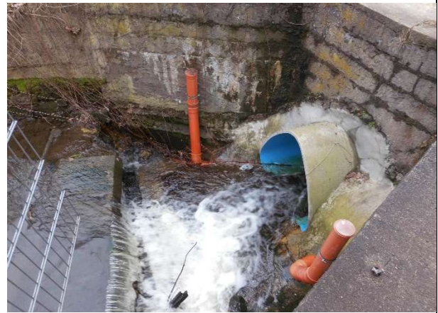
Ansicht Portal oberstrom mit GFK-Rohren
