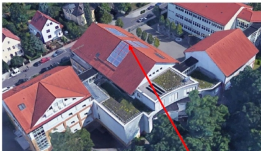
Bild 1 – Übersicht Glasdachkonstruktion Haus A
