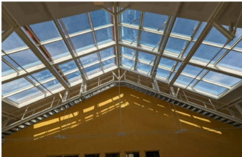
Bild 4 – Gebäudeschnitt Foto vom 04.2024
