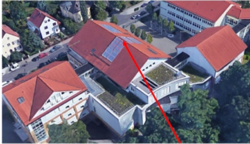
Bild 1 – Übersicht Glasdachkonstruktion Haus A
