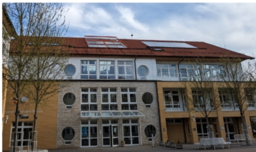
Bild 3 – Südansicht Foto vom 04.2024
