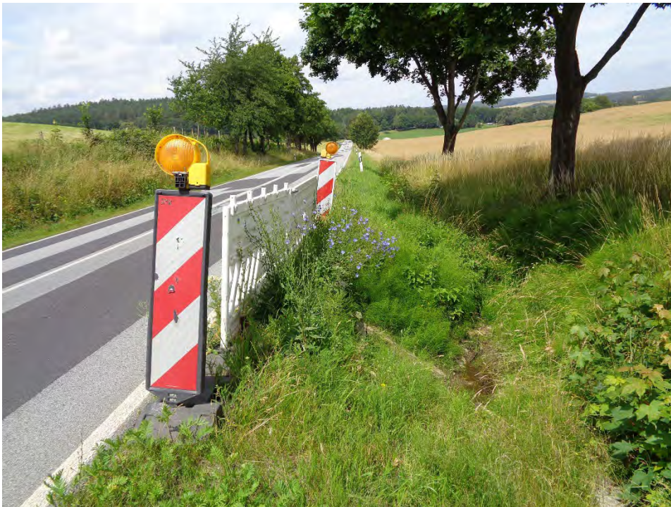
02_Ansicht Absperrung rechter Fahrbahnrand
