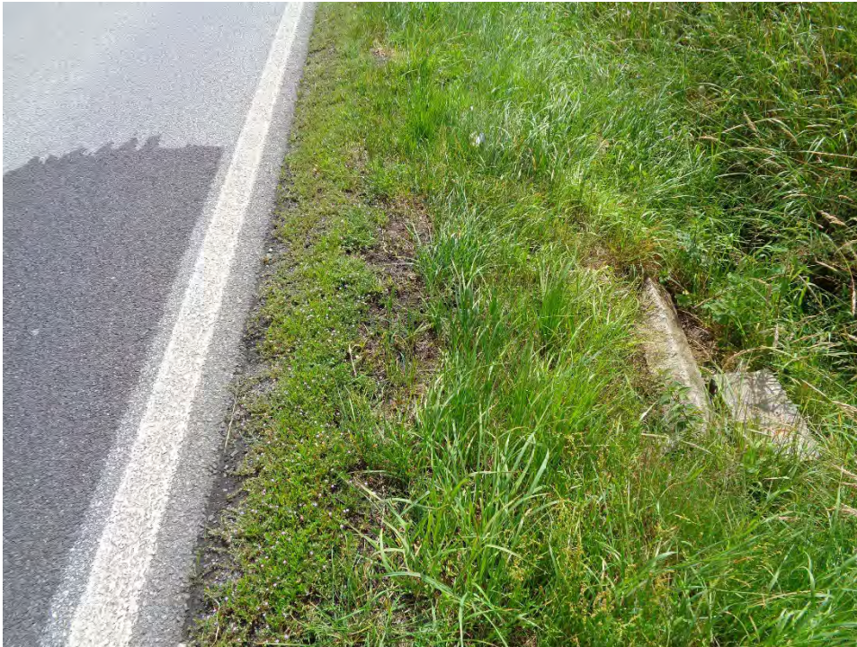
05_Draufsicht Zulaufbereich linker Fahrbahnrand
