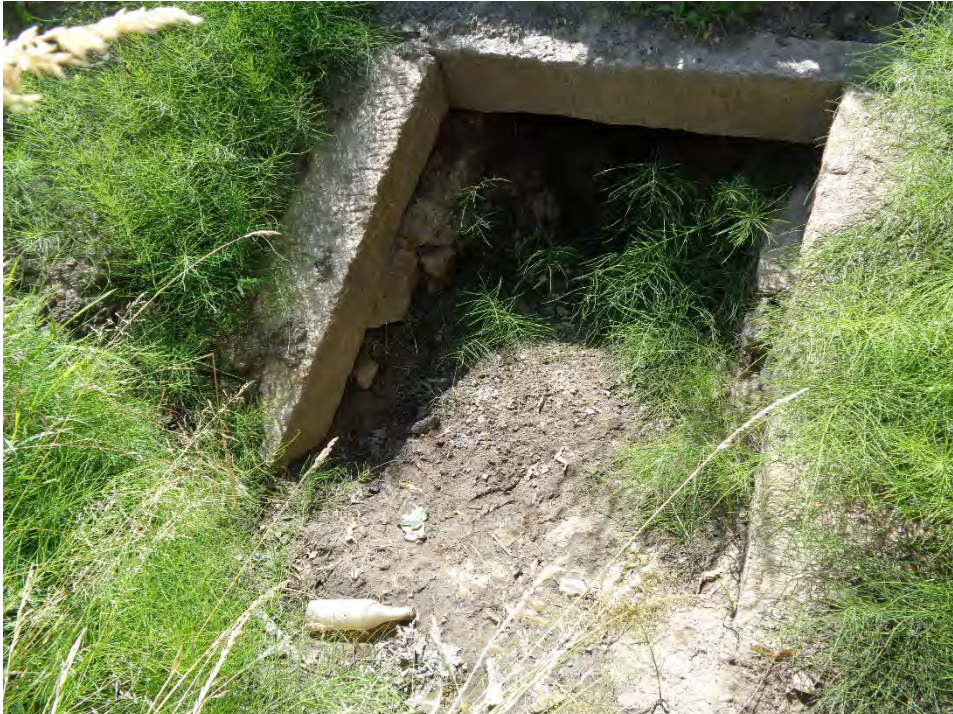
04_Detailansicht Auslaufbereich rechter Fahrbahnrand
