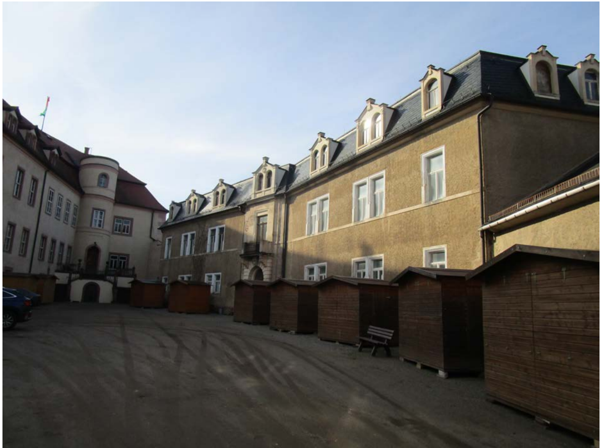
Fassade hofseitig – im hinteren Bereich Anschluss an das Schloss
