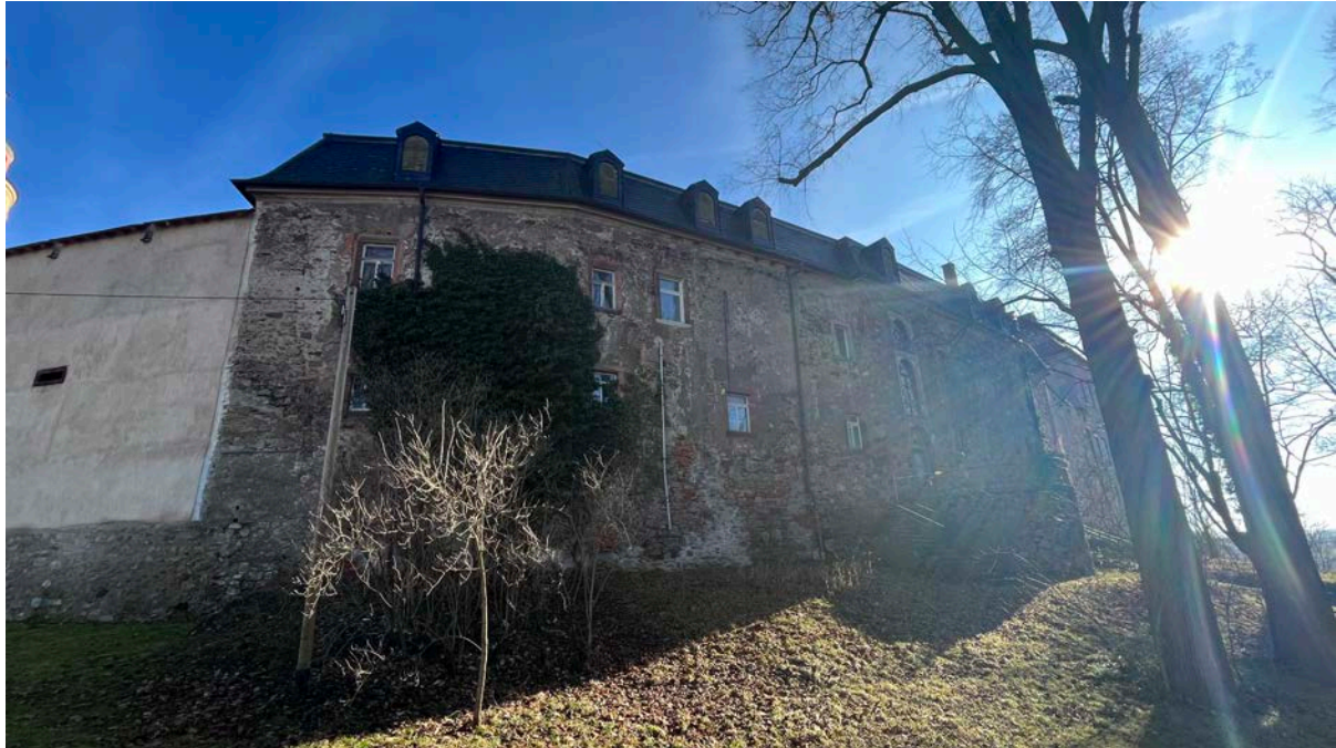
Fassade parkseitig ehemalige Burgmauer – mit Anschluss an Ringmauer Richtung Torturm
