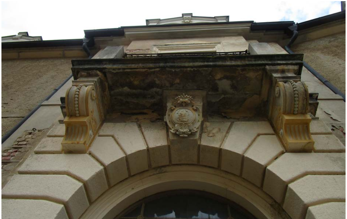
Fassade hofseitig – Untersicht Balkon
