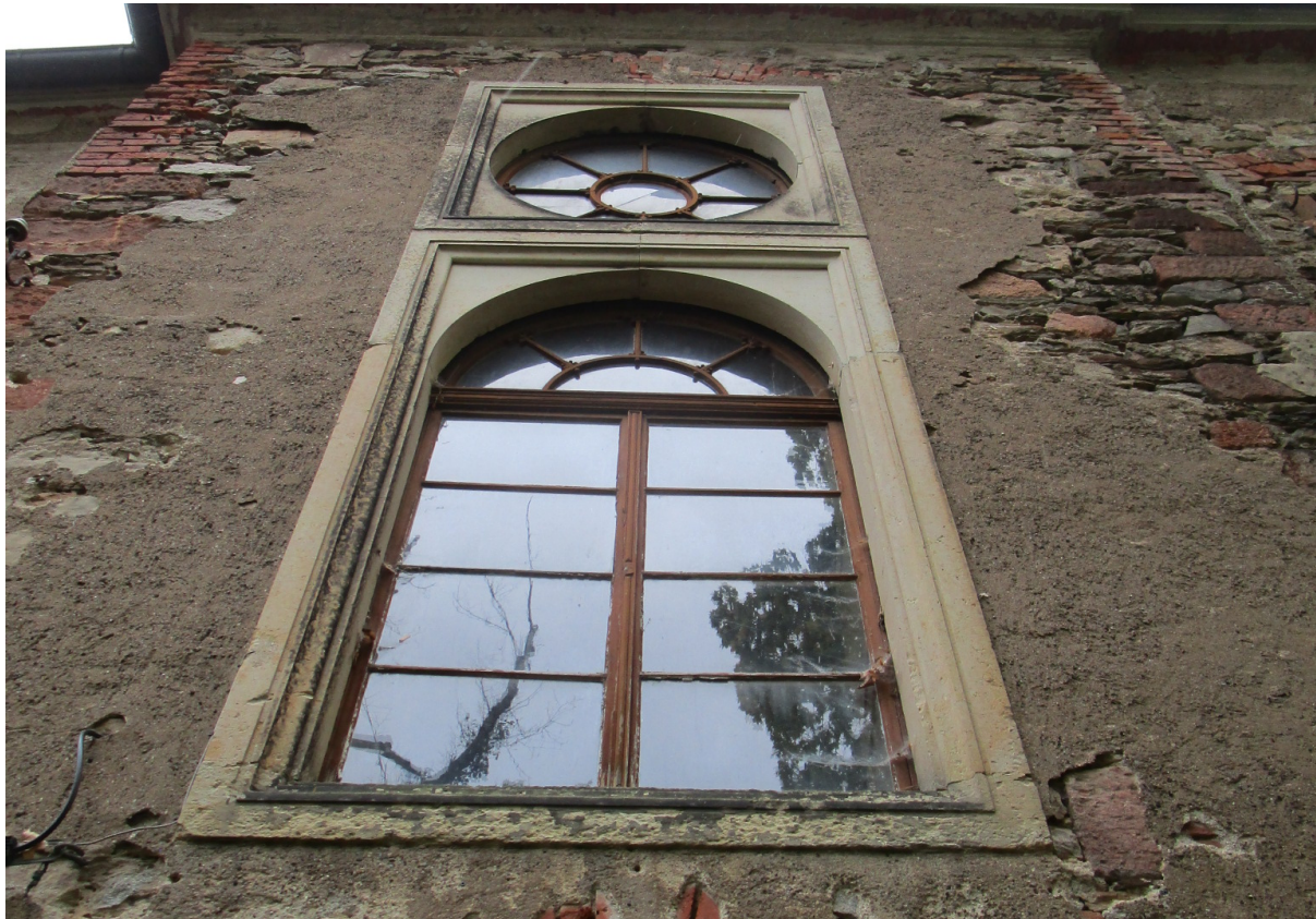
Fassade parkseitig - Sandsteingewände Fenster F1.6
