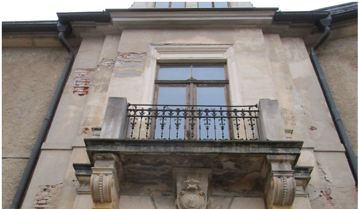
Fassade hofseitig – Mittelrisalit mit Balkon
