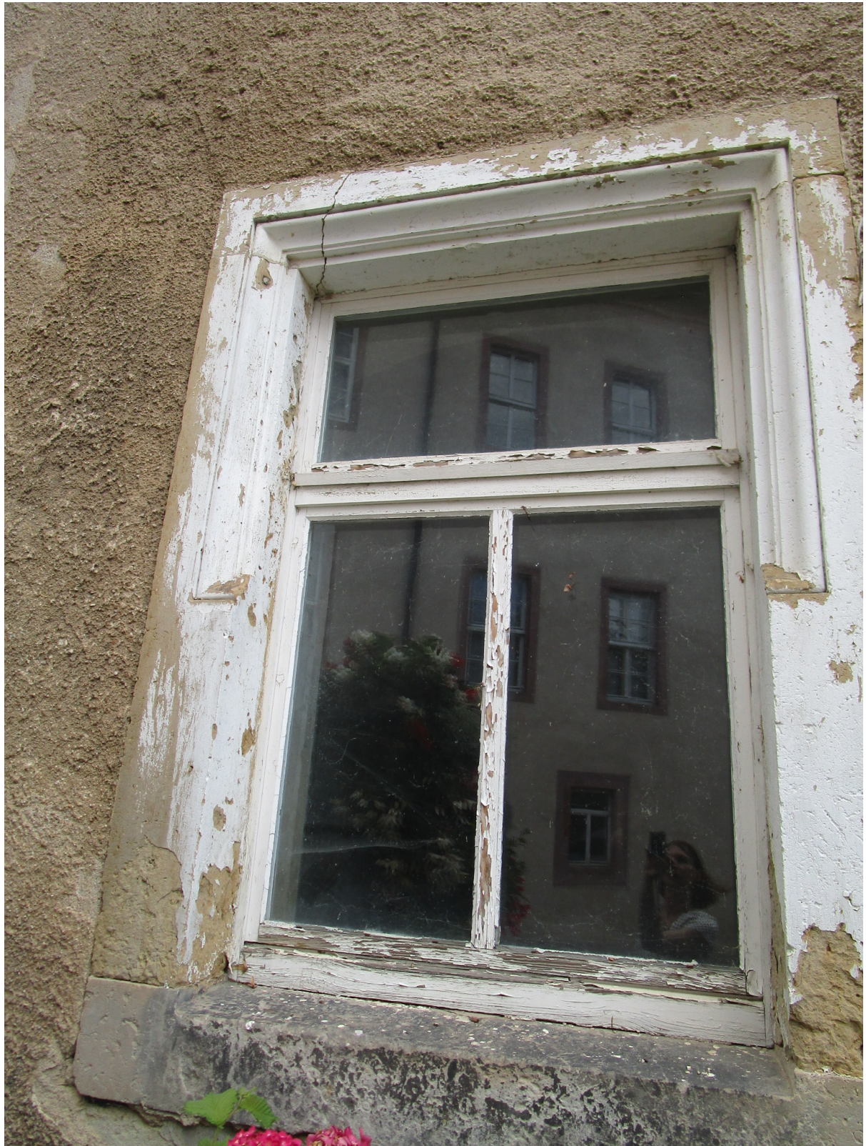
Fassade hofseitig – Sandsteingewände Fenster farblich überfasst
