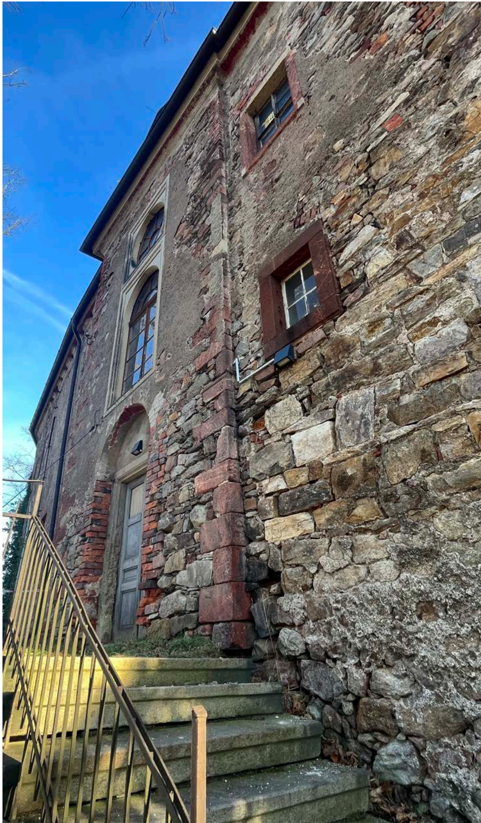
Fassade parkseitig ehemalige Burgmauer - Mittelrisalit (später angelegt)
