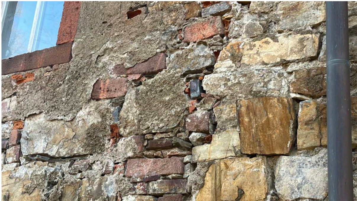
Fassade parkseitig ehemalige Burgmauer – Detailaufnahme Mischmauerwerk
