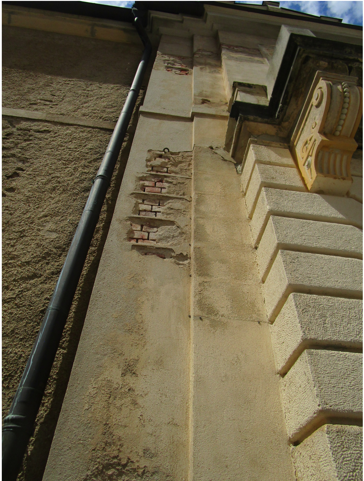
Fassade hofseitig – Mittelrisalit
