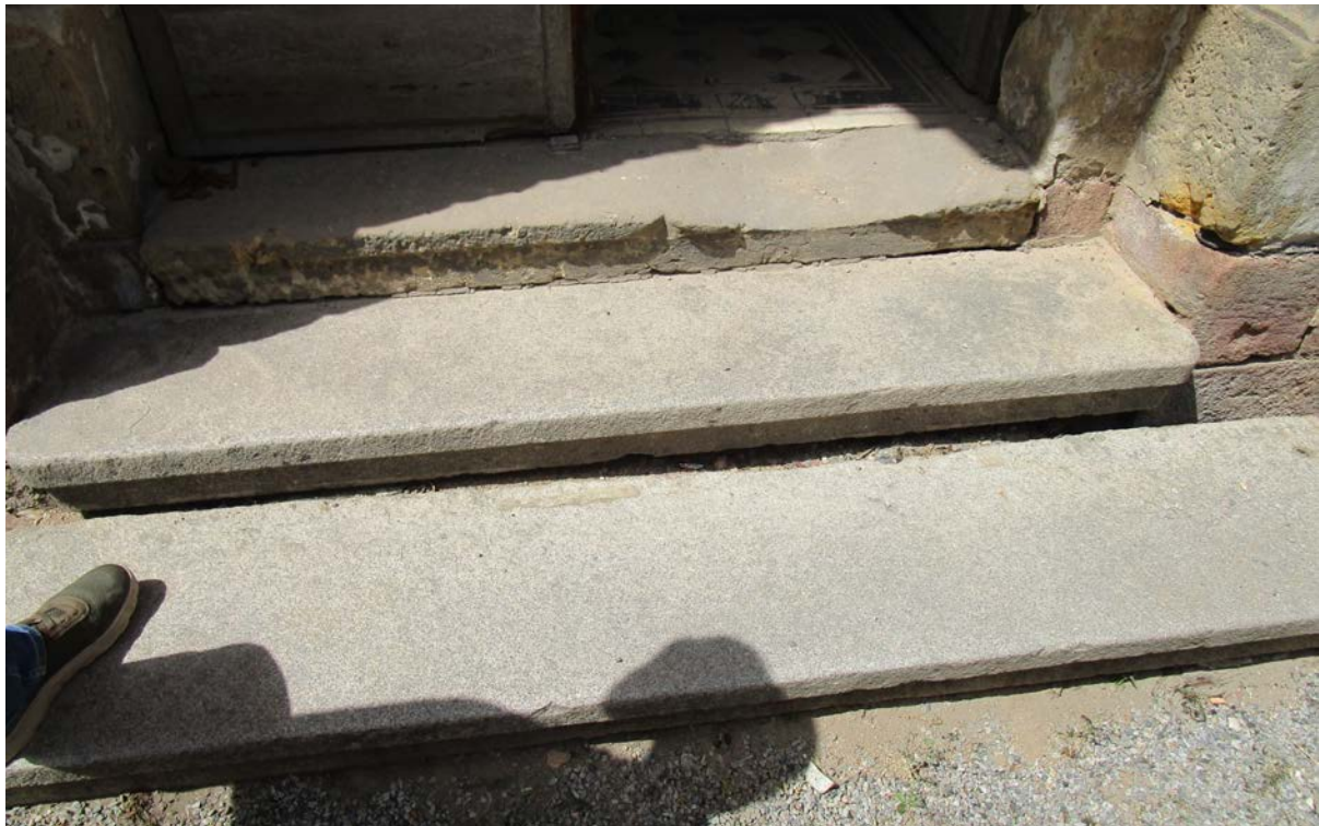
Fassade hofseitig – Eingangstreppe Mittelrisalit
