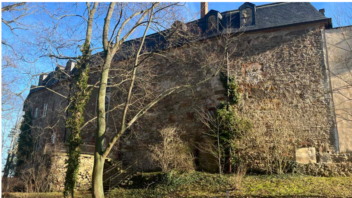
Fassade parkseitig ehemalige Burgmauer – mit Anschluss an Ringmauer Richtung Kanonenhof
