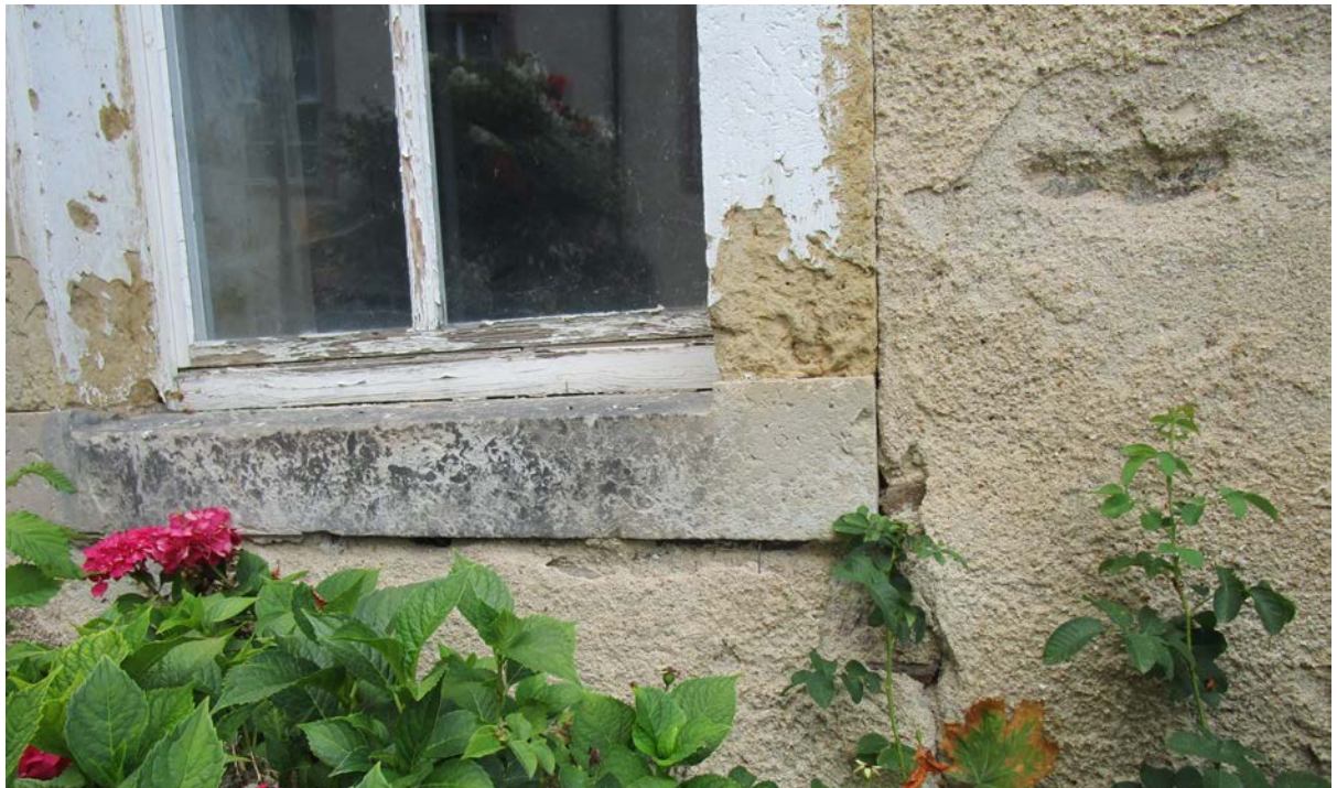
Fassade hofseitig – Sandsteingewände Fenster
