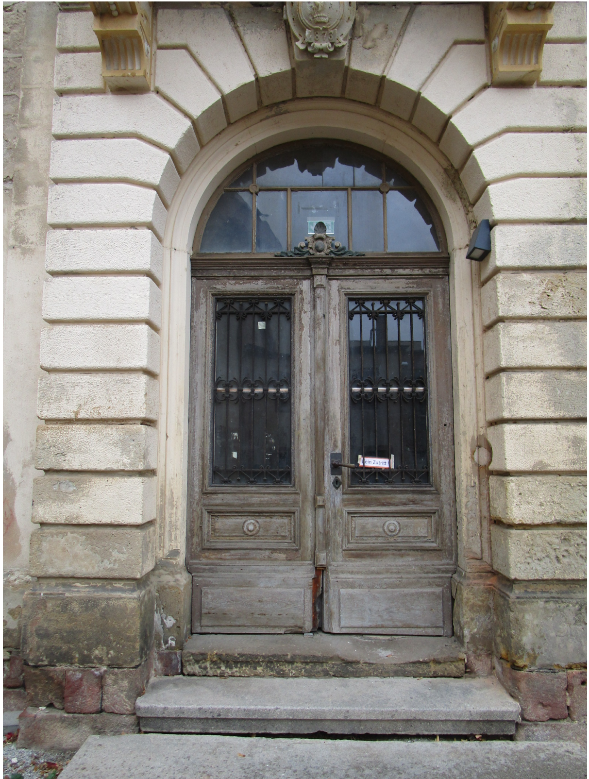
Fassade hofseitig – Mittelrisalit
