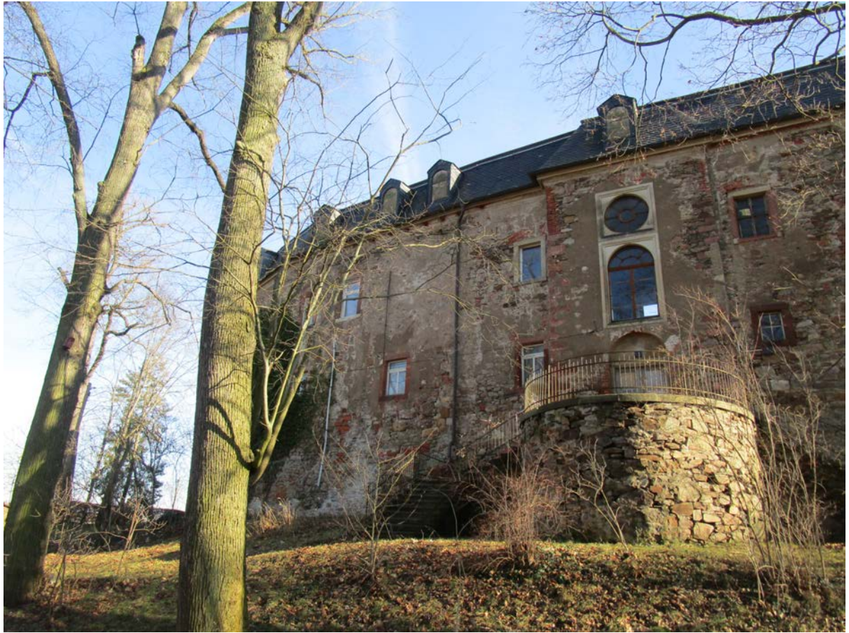
Fassade parkseitig ehemalige Burgmauer – mit Freitreppe (Bildaufnahme vor Sanierung der Freitreppe)
