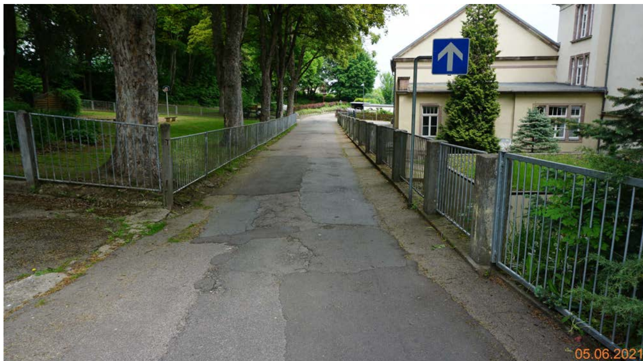
HP 2021-BILD 01-BLICK IN PRÜFRICHTUNG
