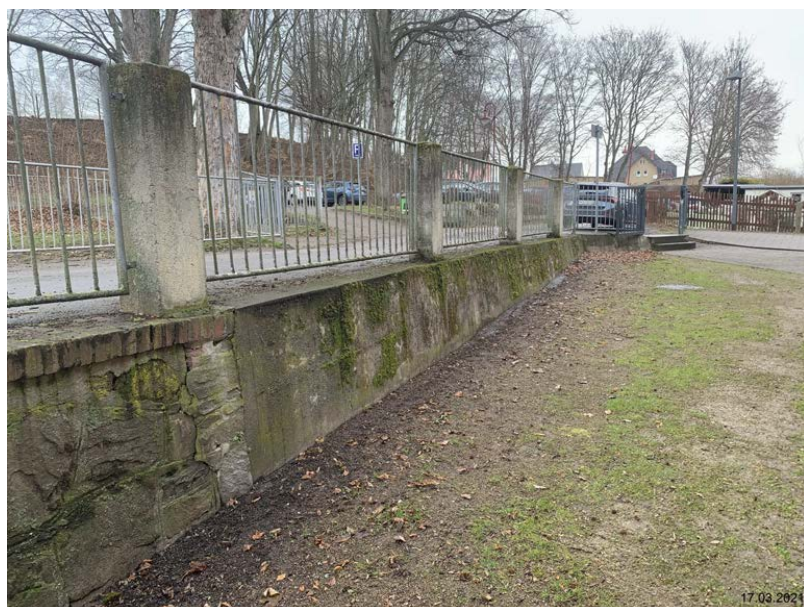
HP 2021-BILD 06-STW ANSICHTSSEITE BLICK VON BWM NACH BWE
